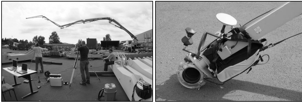
Abb. 2: Messanordnung (a) und Spezialhalterung an der Mastspitze (b)
