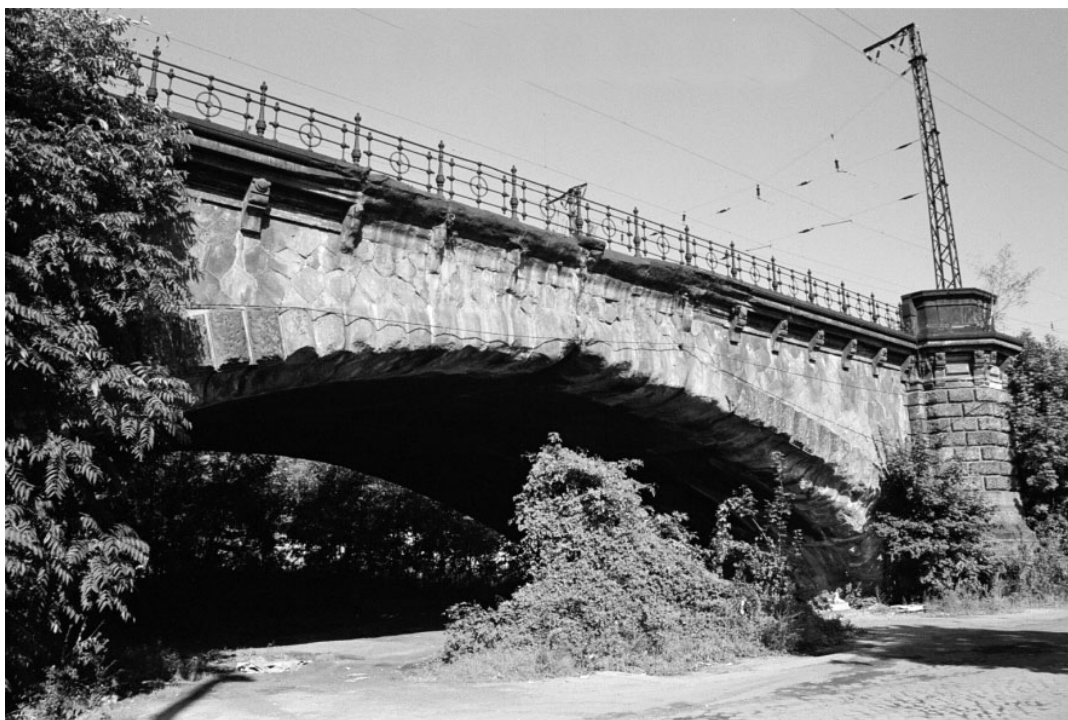
Bild 3.10: Vorlandviadukt im Zustand 2000, Brandschaden Bogen 3
