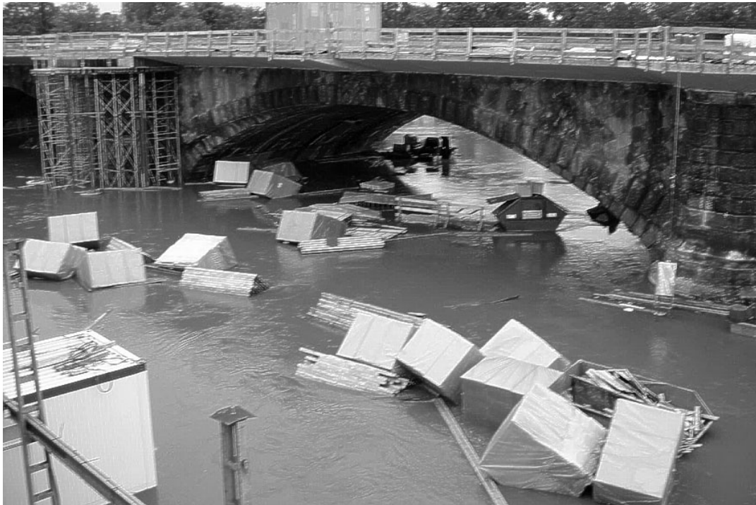
Bild 3.20: Hochwasser August 2002, Baustelleneinrichtung im Bereich des Vorlandviadukts
