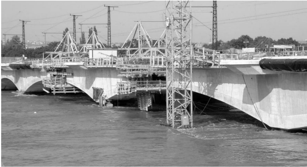
Bild 3.19: Hochwasser August 2002, Freivorbauabschnitt Strombrücke
