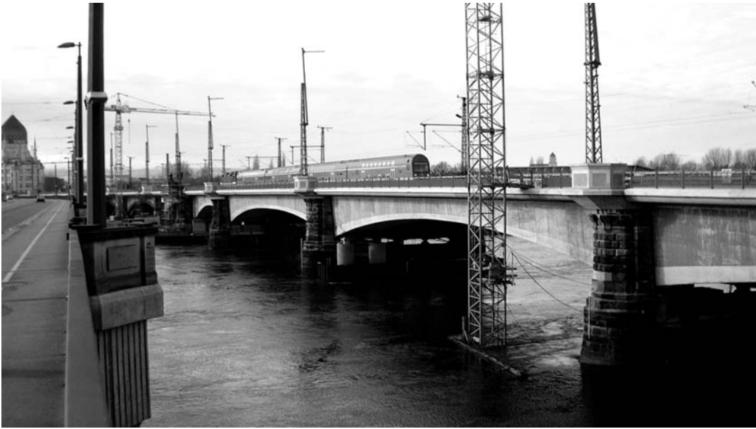
Bild 3.22: Ansicht vom rechten Elbufer nach Fertigstellung Überbau 1
