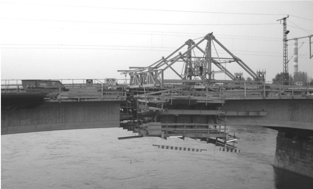
Bild 3.21: Lückenschluß am Überbau 1 bereits wenige Wochen nach dem Hochwasser
