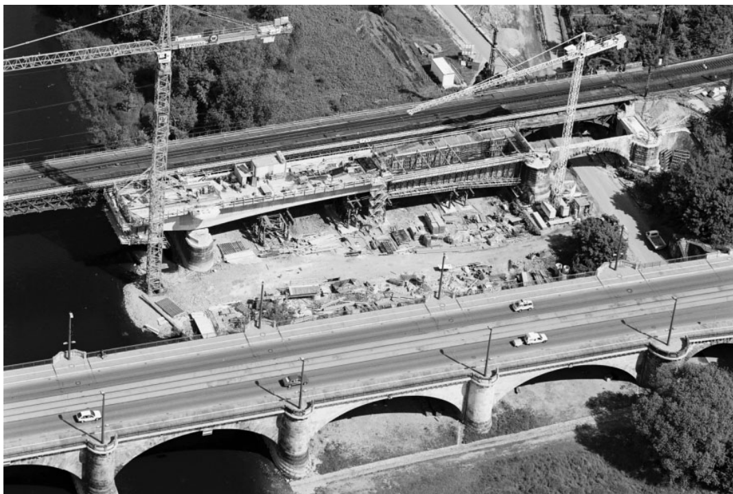
Bild 3.18: Herstellung des Überbaus Feld 4 im Vorlandbereich auf Traggerüst, der Freivorbauwagen an Pfeiler X ist bereits aufgebaut
