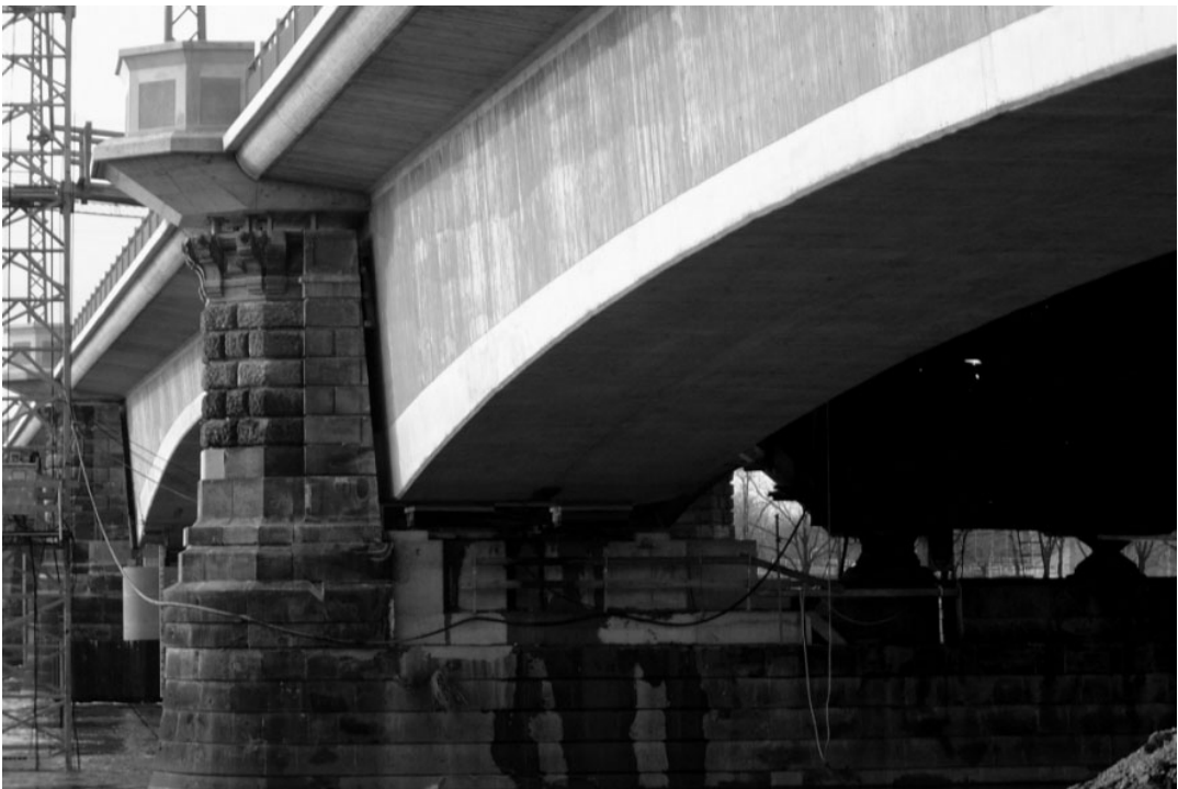
Bild 3.23: Gestaltung der Pfeilerkonsolen
