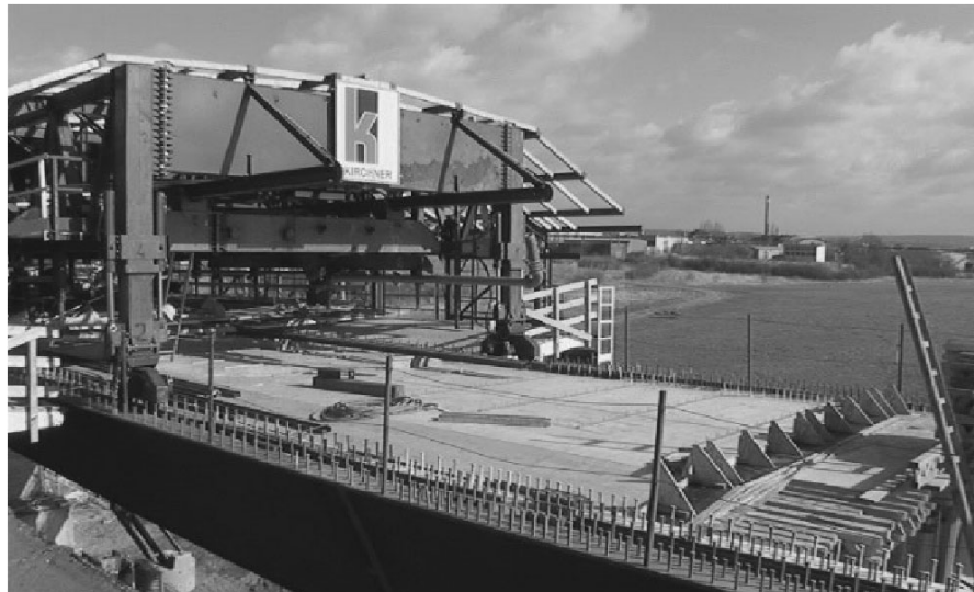
Bild 5.11: Schalwagen zur Herstellung von Verbundplatte und Kappen
