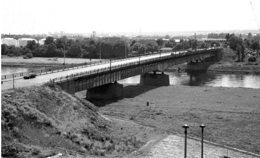
Bild 5.1: Ansicht der alten Brücke
