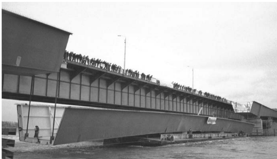
Bild 5.10: Montage des Mittelteiles des östlichen Überbaus
