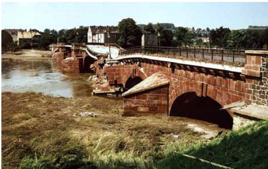
**Bild 2.1:** Hochwasserschaden in Sachsen
