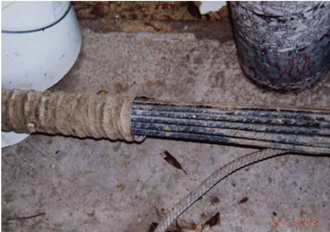
Bild 9.14: Bündelspannglied BSG 100, geöffnet, Zustand des Spannstahles St 140/160 sehr gut
