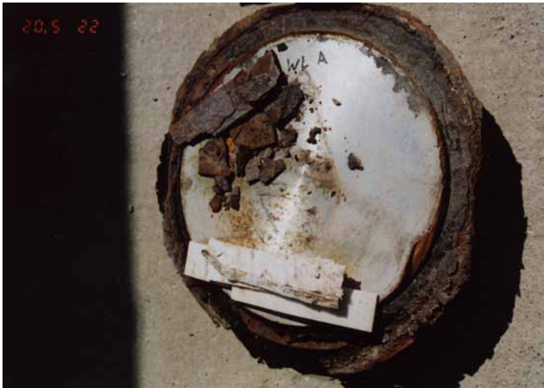
Bild 9.23: Gleitlager vom WL A (Neuwernsdorf); außen katastrophaler Zustand, Schalenrost, innen noch gute Beschaffenheit
