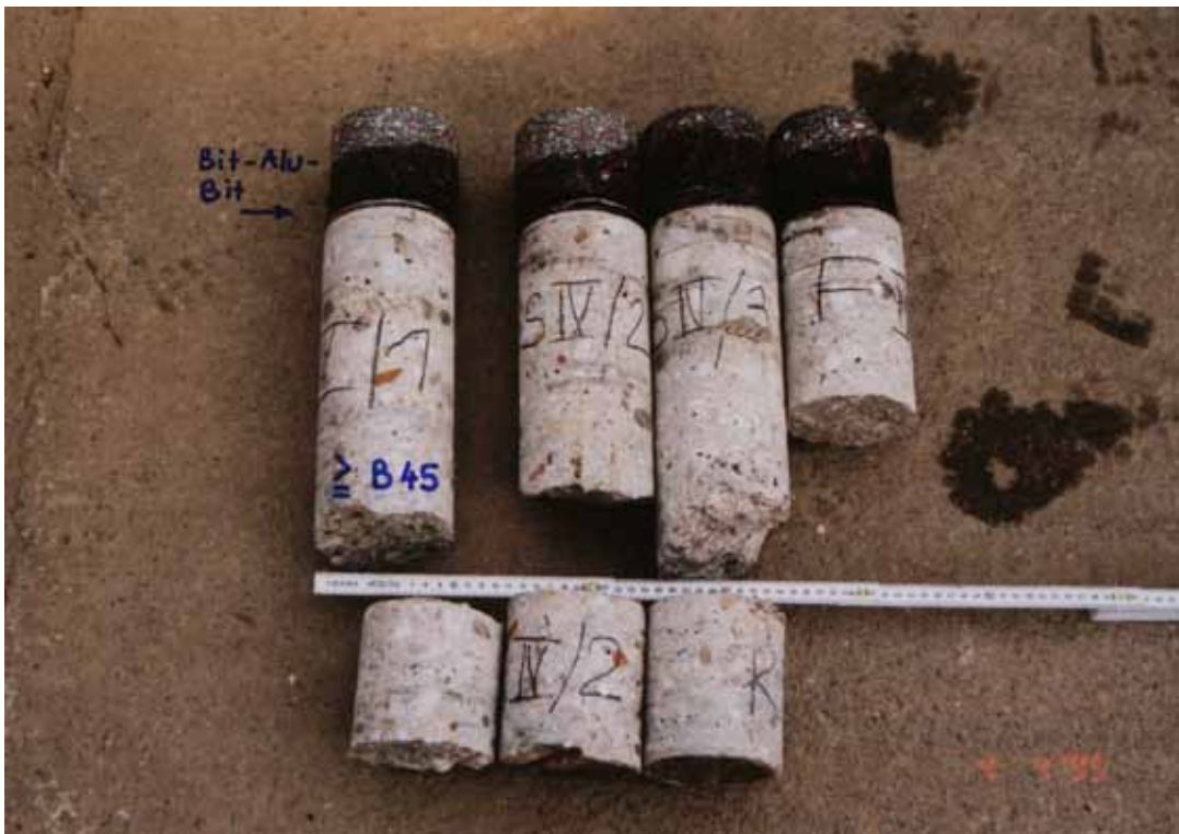
Bild 9.13: Bohrkern aus dem Überbau: Gußasphalt - Abdichtung - Tragwerksbeton
