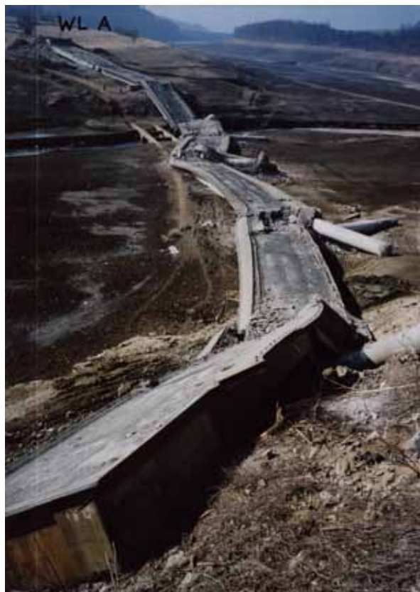
Bild 9.7: Zustand unmittelbar nach der Sprengung, Blick in Richtung WL Neuwernsdorf
