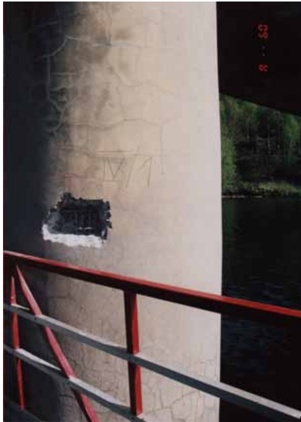
Bild 9.18: Untersuchungen an Stützen1995, Netzrisse im „Mantelbeton“ deutlich sichtbar
