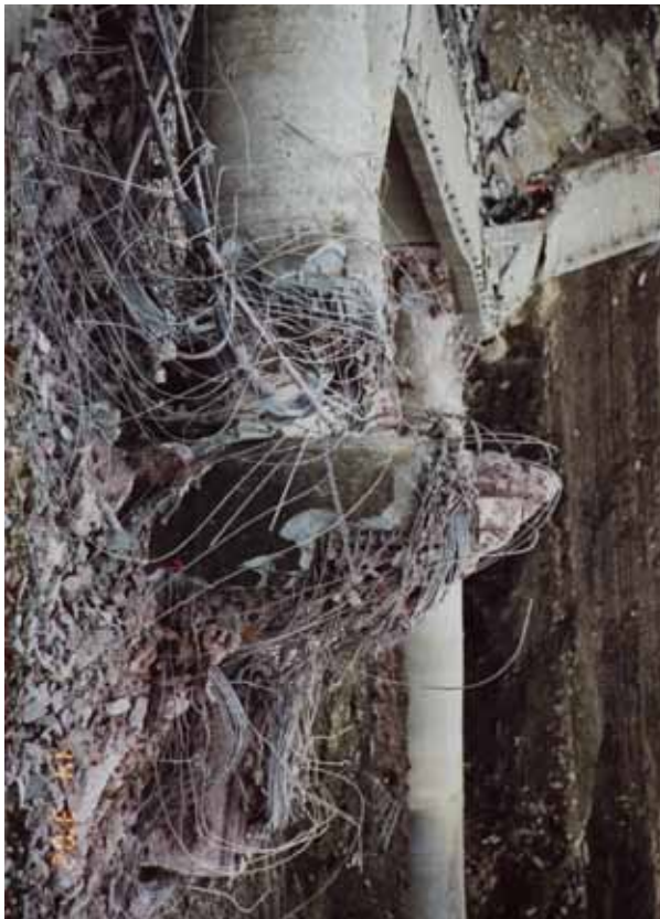
Bild 9.9: Gesprengter Stützenfuß, Bergung erster Teile
