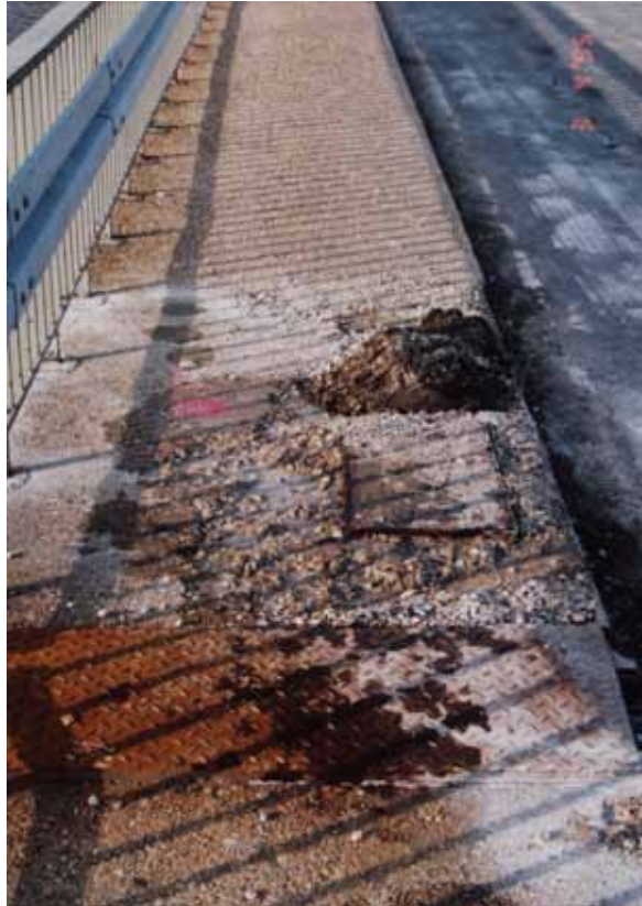
Bild 9.11: Starke Korrosion an Stahlbauteilen und am Beton, hier im Kappenbereich (Zustand 1995), Beton konnte teilweise abgekehrt werden
