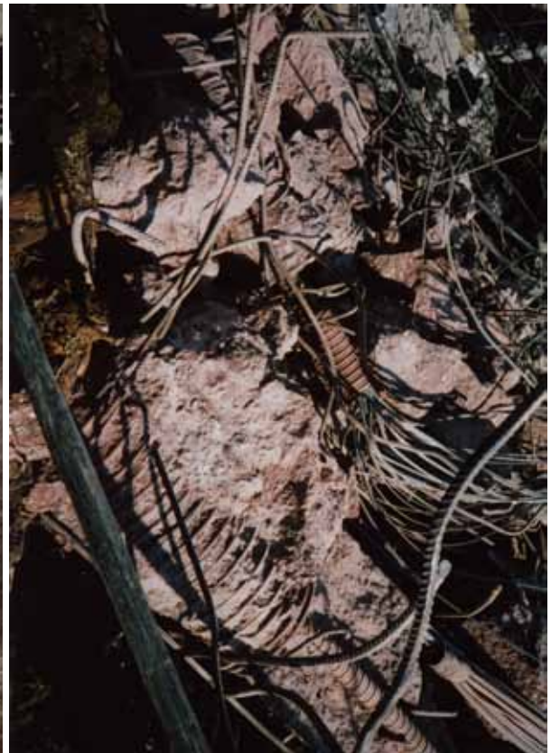
Bild 9.10: Sichtung und Herausarbeiten wesentlicher Spanngliedteile kurz nach der Sprengung
