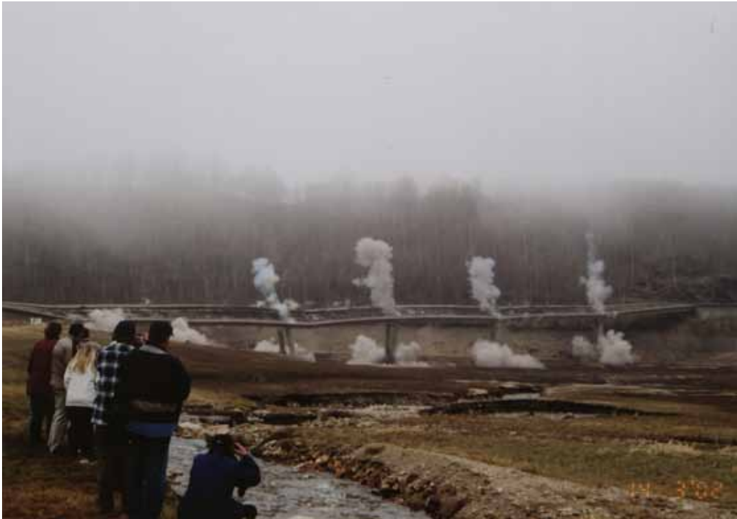
Bild 9.6: Sprengung des Bauwerks am 14.03.2002
