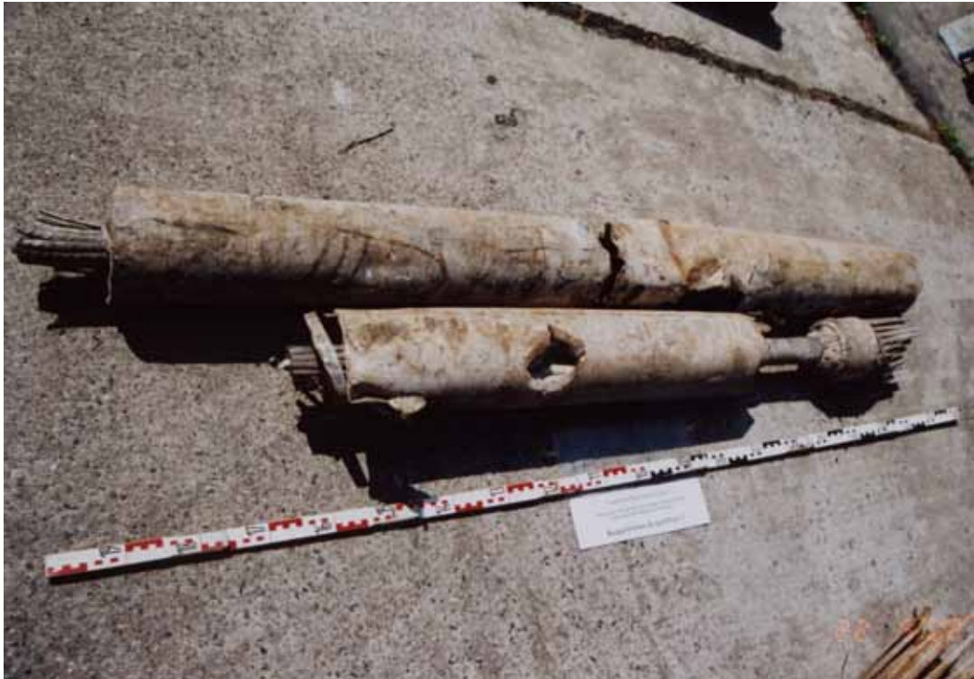
Bild 9.16: Koppelfuge 2, komplette Verbindungen
