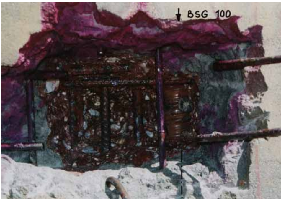
Bild 9.19: Meßstelle w. v., rechts Erkundung Spannglied BSG 100 bis zum Stahl
