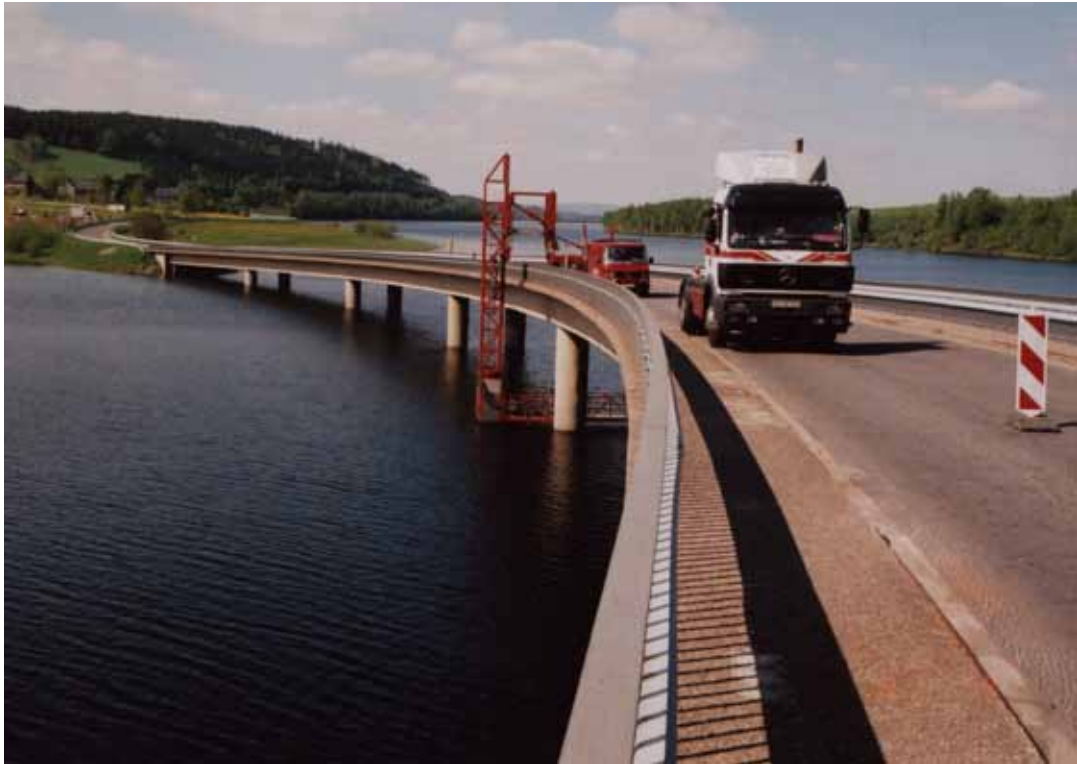
Bild 9.1: Brückenansicht bei Volleinstau, 1995
