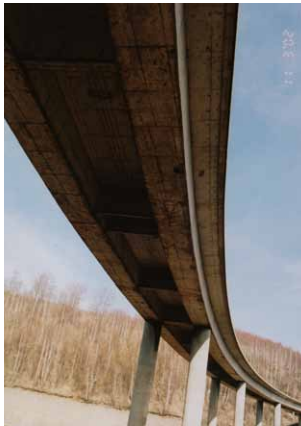
Bild 9.2: Brückenuntersicht unmittelbar vor der Sprengung, März 2002
