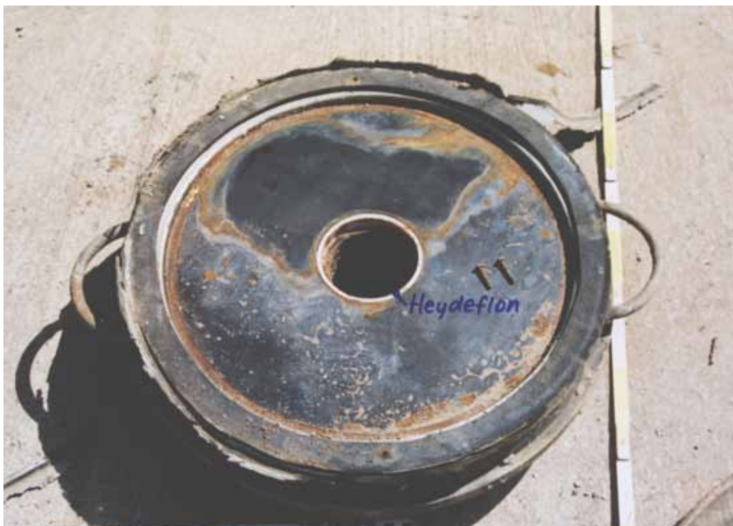
Bild 9.24: Kiplager, hier von Stützenreihe 6
