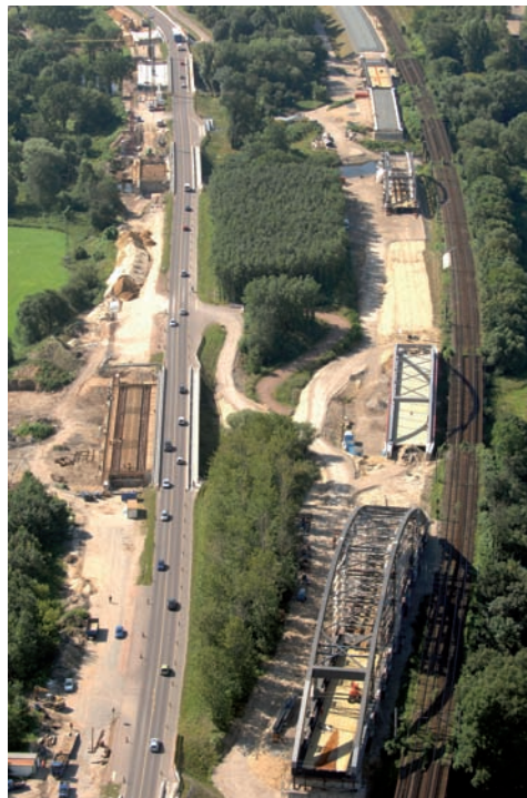
Bild 1.25: Eisenbahnknoten Dessau - Roßlau, Bereich Muldequerung. Foto: Schüßler-Plan Ingenieurgesellschaft mbH, Berlin
