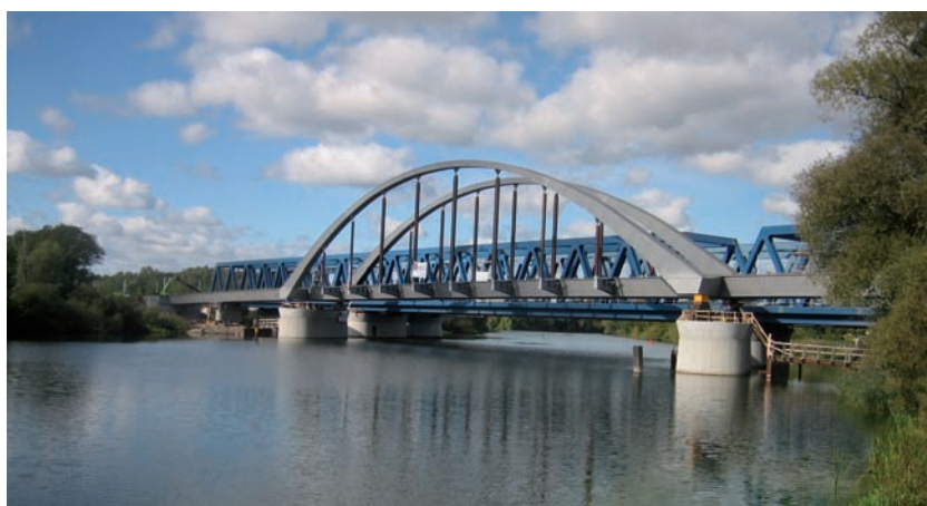
Bild 1.49: Havelbrücke im Zuge der B 188n, OU Rathenow - Ansicht, Foto: LBS Brandenburg
