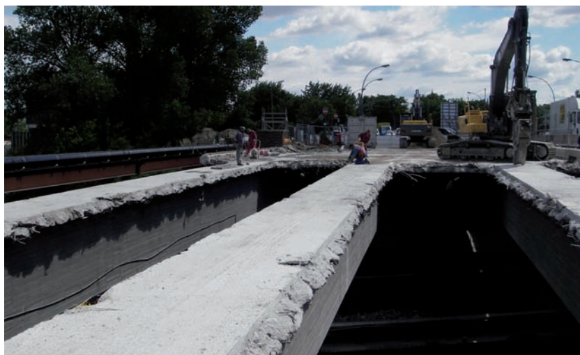
Bild 1.56: Ludwig-Hoffmann-Brücke über den Westhafen-Kanal in Berlin-Mitte - Abbruch der Fahrbahnplatte, Foto: VIC BB GmbH
