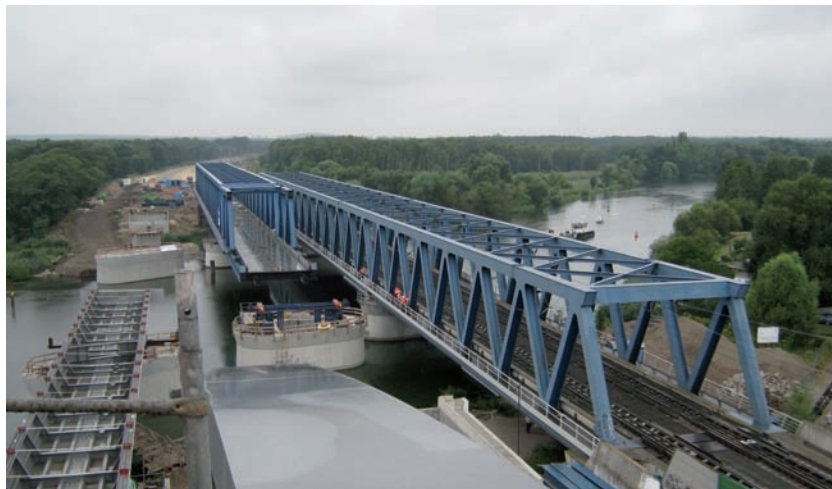
Bild 1.48: EÜ Havelbrücke Rathenow in Bildmitte beim Vorschub - rechts die HGV-Strecke, links die Havelbrücke im Zuge der B 188 beim Vorschub (Blick vom Bogenscheitel), Foto: LBS Brandenburg
