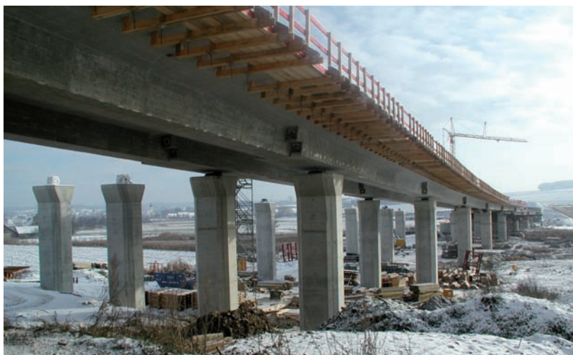
Bild 1.12: Brücke über die Kleine Laaber im Zuge der B 15n - Bau der RF Landshut, Foto: ABD Südbayern
