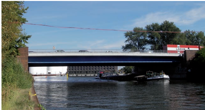
Bild 1.55: Ludwig-Hoffmann-Brücke über den Westhafen-Kanal in Berlin-Mitte - Ansicht, Foto: VIC BB GmbH
