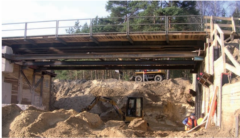
Bild 1.53: EÜ Ferch Lienewitz - hinter einem Widerlager eingebaute Hilfsbrücke HB ZH5, Foto: EHS Magdeburg
