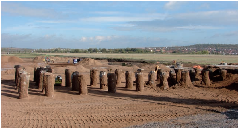
Bild 1.24: Brücke über die Unstrut im Zuge der A 71, Schotterstopfsäulen, Foto: DEGES
