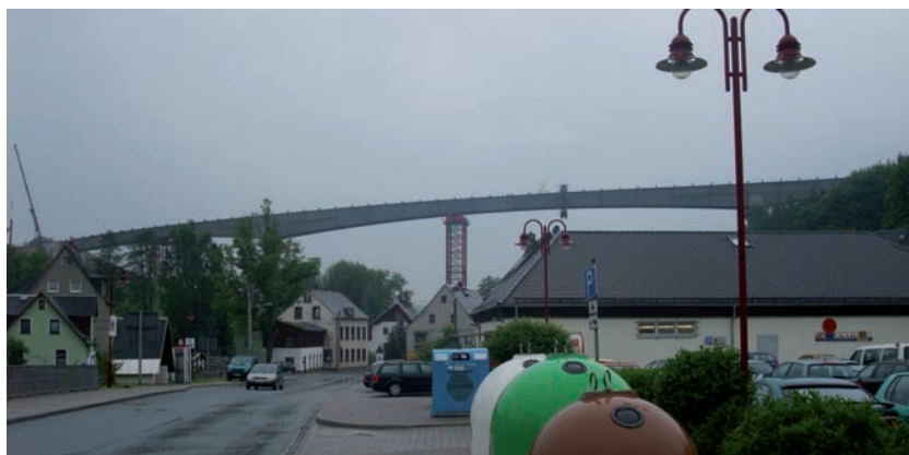
Bild 1.33: Talbrücke über die Große Mittweida im Zuge der B 101 OU Markersbach - Blick auf das Mittelfeld mit Hilfsstütze, Foto: SBA Plauen/ZG Bad Schlema
