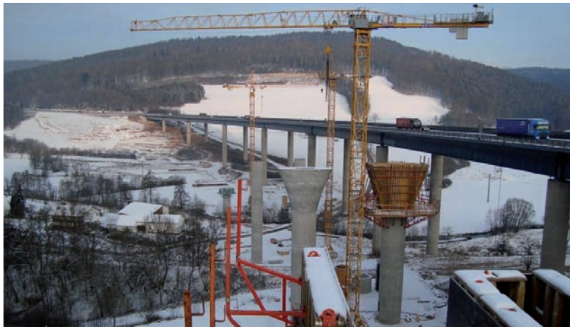
Bild 1.11: Sinntalbrücke im Zuge der A 7, Foto: ABD Nordbayern
