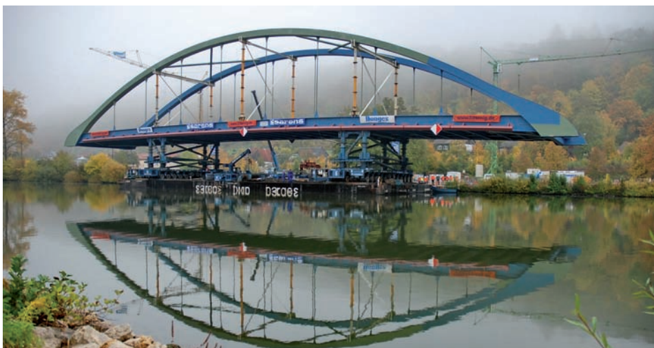
Bild 1.3: Mainbrücke Segnitz - Einschwimmen des Stabbogens mittels Pontons, Foto: SBA Würzburg
