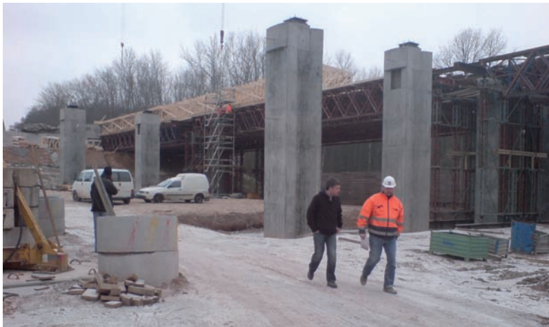
Bild 1.42: Ossabachtalbrücke im Zuge der A 72 Chemnitz - Leipzig, Foto: DEGES
