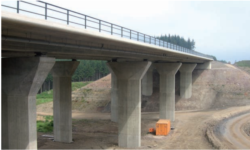
Bild 1.15: Talbrücke Königsuhr im Zuge der Eifelautobahn A 1, Foto: LBM Rheinland-Pfalz
