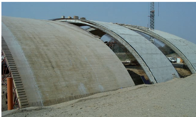
Bild 1.59: Grünbrücke Hainholz - Betonierabschnitte, Foto: LBV Schleswig-Holstein
