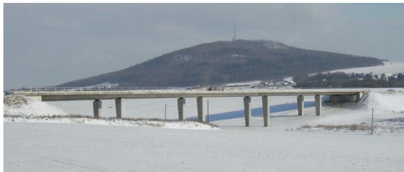
Bild 1.29: Talbrücke Kleinschweidnitz im Zuge der B 178n, Foto: SBA Bautzen
