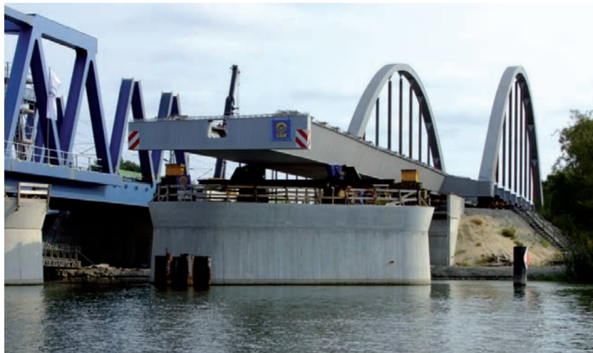
Bild 1.51: Havelbrücke im Zuge der B 188n, OU Rathenow - 1. Längsverschub, Foto: LBS Brandenburg
