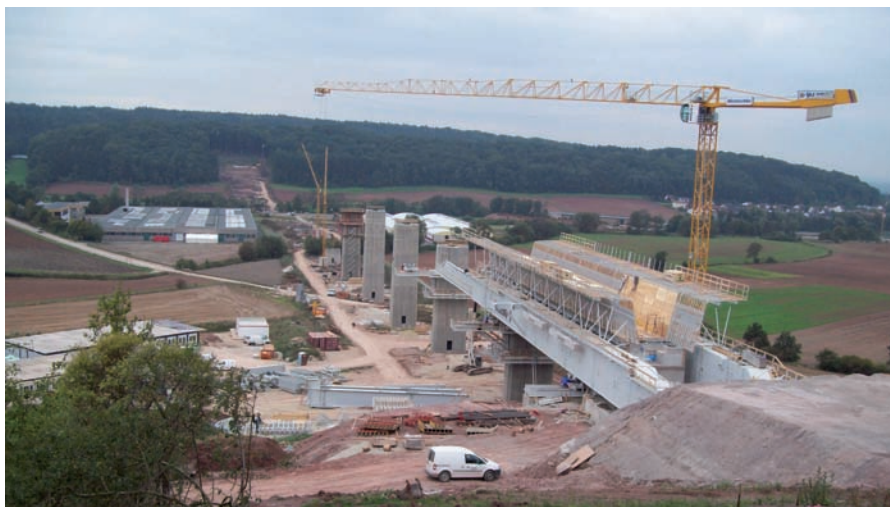
Bild 1.18: Füllbachtalbrücke im Zuge der NBS Ebensfeld - Erfurt, Foto: DB ProjektBau
