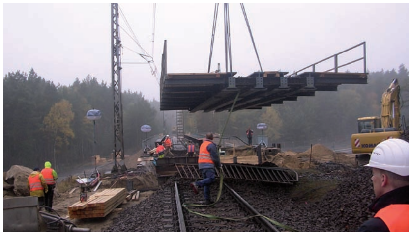
Bild 1.54: EÜ Ferch Lienewitz - Montage einer der beiden Hilfsbrücken HB ZH5, Foto: EHS Magdeburg
