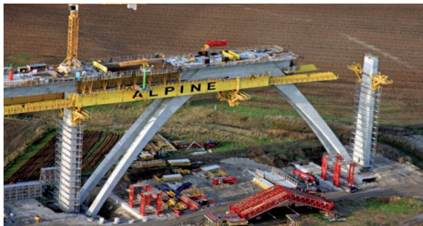
Bild 1.23: Unstruttalbrücke im Zuge der NBS Erfurt - Halle/Leipzig - Vorschubgerüst am ersten Bogen über dem Dissaugaben, Foto: DB AG
