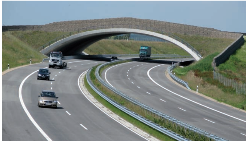
Bild 1.58: Grünbrücke Hainholz, Foto: LBV Schleswig-Holstein
