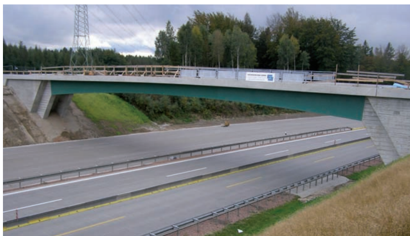
Bild 1.40: Wirtschaftswegüberführung über die A 4 bei Wüstenbrand - Ansicht, Foto: DEGES
