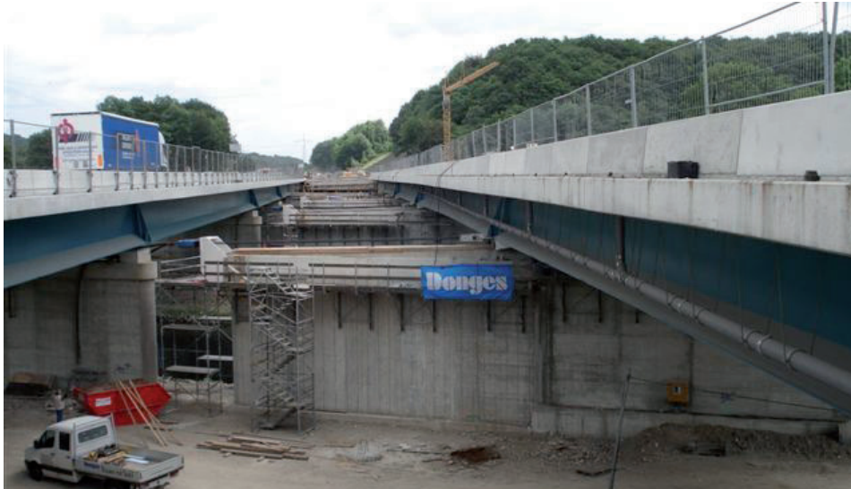
Bild 1.46: Lennebrücke im Zuge der A 1 - Querverschub des südlichen Überbaus mittels Litzenhubtechnik am 3.6.2009, Foto: DONGES
