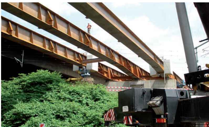
Bild 1.45: Brücke über den Bahnhof Hagen-Kabel im Zuge der A 1, Foto: DONGES
