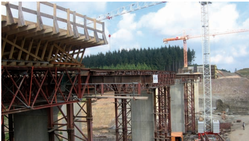
Bild 1.16: Talbrücke Königsuhr - bodengestütztes Lehrgerüst, Foto: Adam Hörnig
