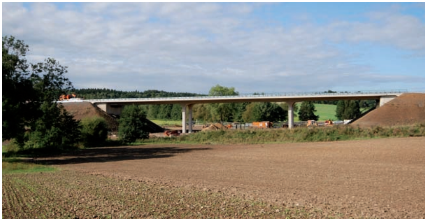
Bild 1.31: Brücke über das Fischbachtal im Zuge der B 101 bei Großschirma - Ansicht, Foto: SBA Chemnitz
