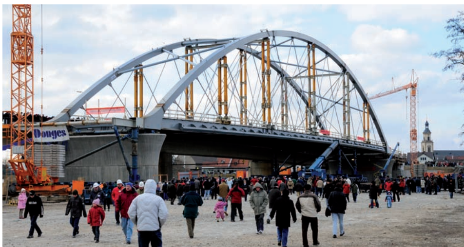
Bild 1.2: Mainbrücke Bergtheinfeld - fertiges Bauwerk, Foto: Adam Hörnig
