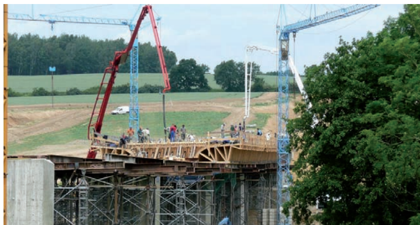
Bild 1.30: Wesenitzbrücke im Zuge der OU Bischofswerda, Foto: SMWA
