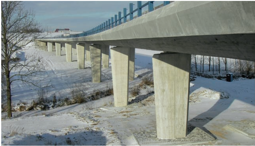
Bild 1.27: Talbrücke Liebesdörfel im Zuge der B 178n, Foto: SBA Bautzen
