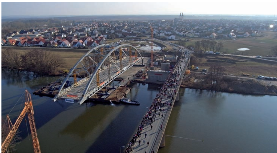
Bild 1.1: Mainbrücke Bergtheinfeld - Einschwimmen der Strombrücke, Foto: SBA Schweinfurt
