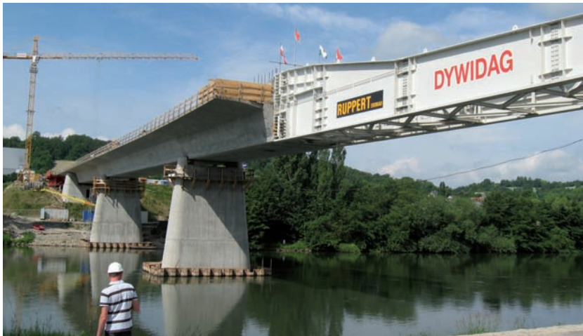
Bild 1.5: Mainbrücke Goßmannsdorf, Foto: DYWIDAG
