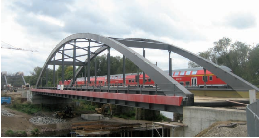
Bild 1.26: EÜ Muldebrücke im Zuge des Eisenbahnknotens Dessau - Roßlau / Bereich Muldequerung, Foto: Schüßler-Plan Ingenieurgesellschaft mbH, Berlin
