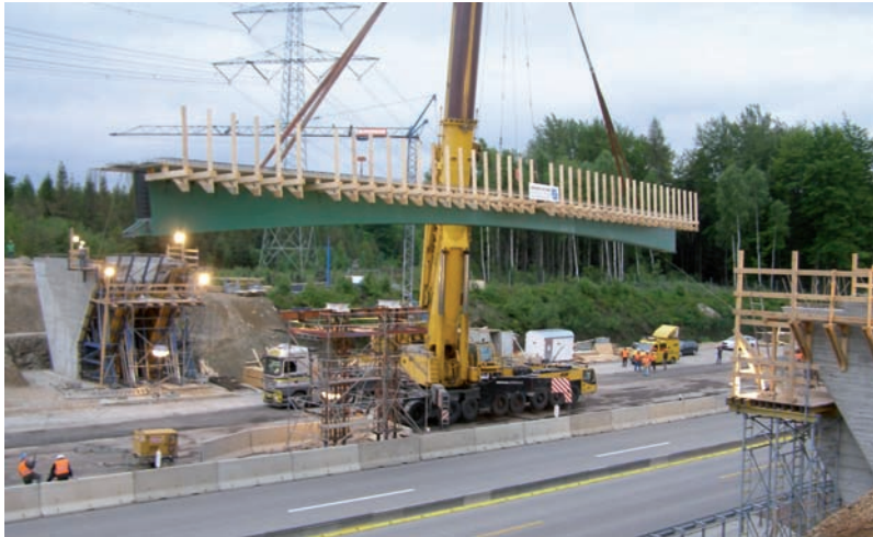
Bild 1.41: Wirtschaftswegüberführung über die A 4 bei Wüstenbrand - Montage der Stahlverbundkästen, Foto: DEGES
