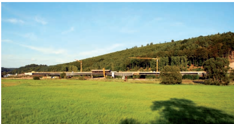
Bild 1.17: Lahnbrücke Marburg im Zuge der B 3, Foto: DONGES
