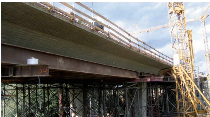
Bild 1.28: Krummbachtalbrücke im Zuge der B 178n, Foto: SBA Bautzen
