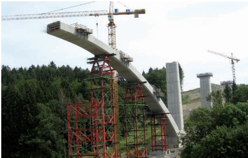
Bild 1.21: Truckenthalbrücke - Bogenfreivorbau unter Einsatz stählerner Hilfsstützen, Foto: BUNG GmbH
