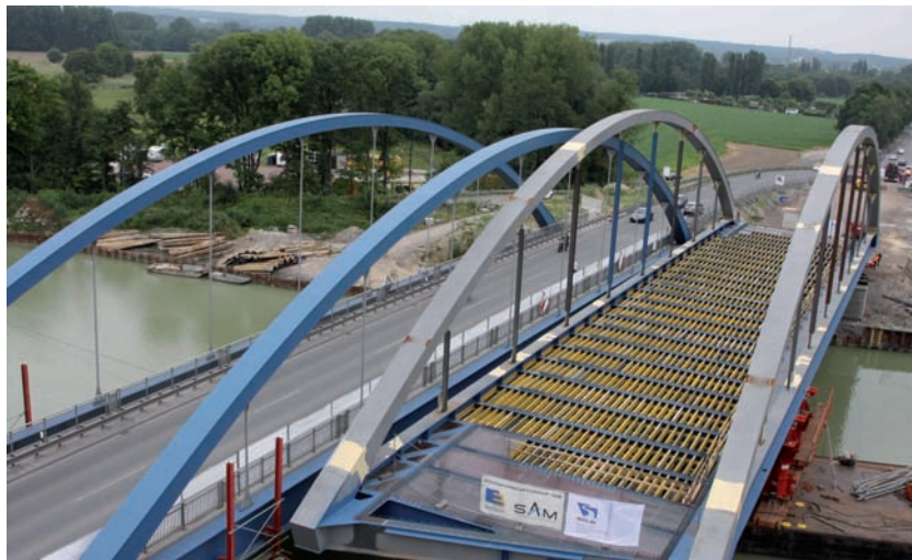
Bild 1.47: Dortmunder Straßenbrücke über den Datteln-Hamm-Kanal - Längseinschub des östlichen Überbaus, Foto: WSA Rheine
