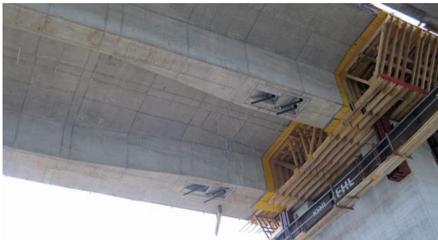
Bild 1.8: Talbrücke Schallermühle - Verankerung der Spannglieder jeweils vor und hinter den Stützen im Bereich der Stegunterseiten, Foto: ABD Nordbayern
