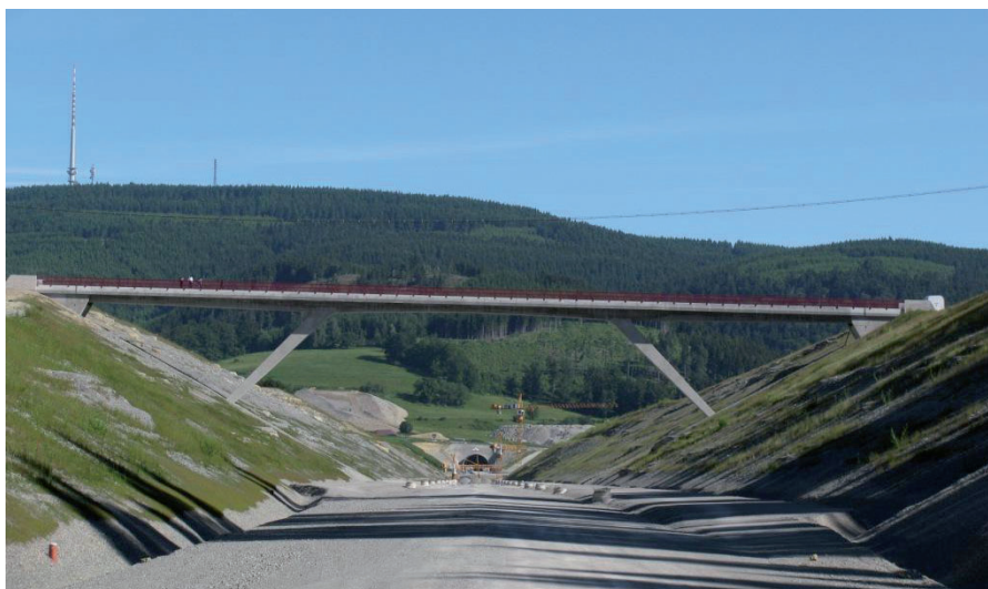
Bild 1.19: Wirtschaftswegüberführung Einschnitt Theuern, Foto: BUNG GmbH
