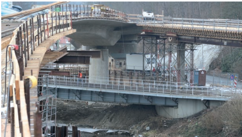
Bild 1.44: Einbindung der Geh- und Radwegrampe des Elsterradweges in die Brücke der B 92 OU Elsterberg über die Weiße Elster, Foto: SMWA
