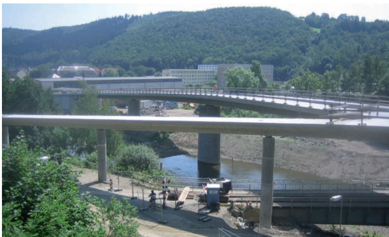
Bild 1.43: Brücke über die Weiße Elster im Zuge der OU Elsterberg B 92 - im Vordergrund Geh- und Radwegbrücke, Foto: SMWA
