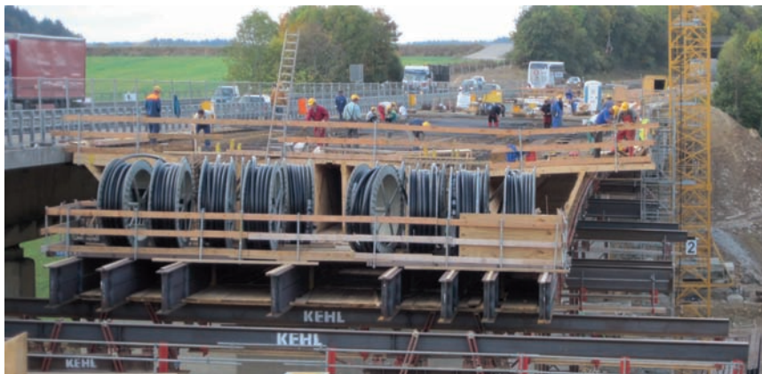
Bild 1.9: Talbrücke Schallermühle - Blick auf die verbundlosen, internen SUSPA-Drahtspannglieder, Foto: ABD Nordbayern
