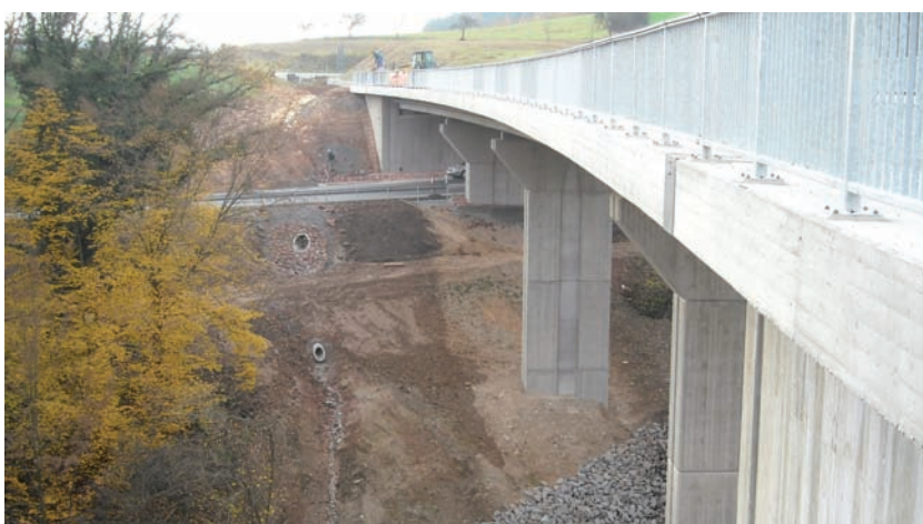
Bild 1.6: Glasbachtalbrücke westlich Marktheidenfeld, Foto: SBA Würzburg
