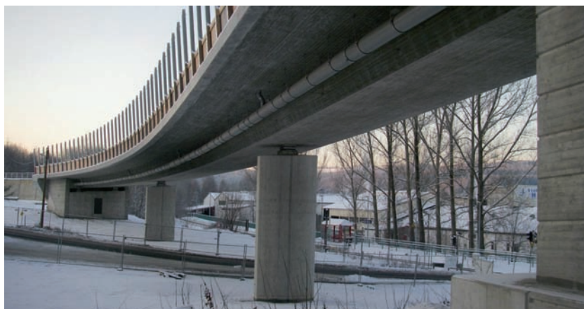
Bild 1.37: Brücke über die Schweddey, Foto: DEGES/VIC GmbH
