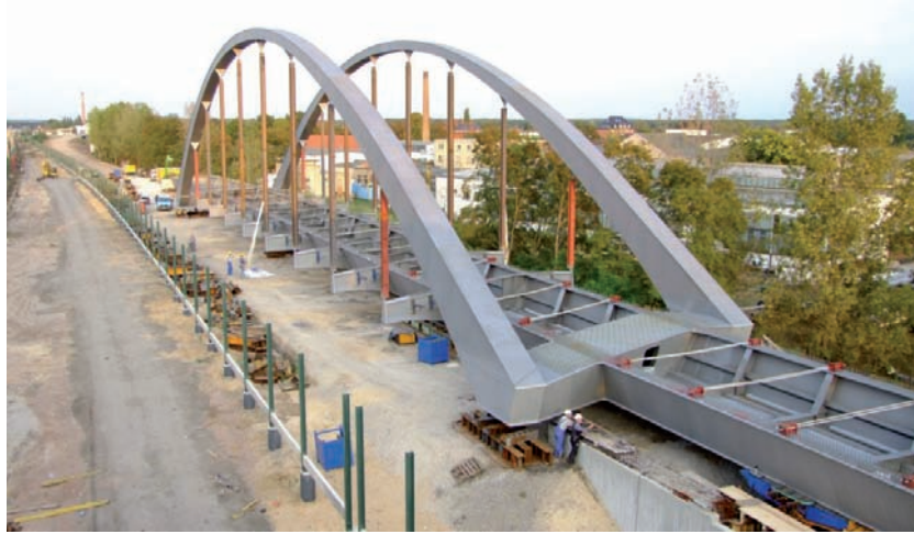
Bild 1.50: Havelbrücke im Zuge der B 188n, OU Rathenow - Blick auf den Vormontageplatz während des Längsverschubs, Foto: LBS Brandenburg
