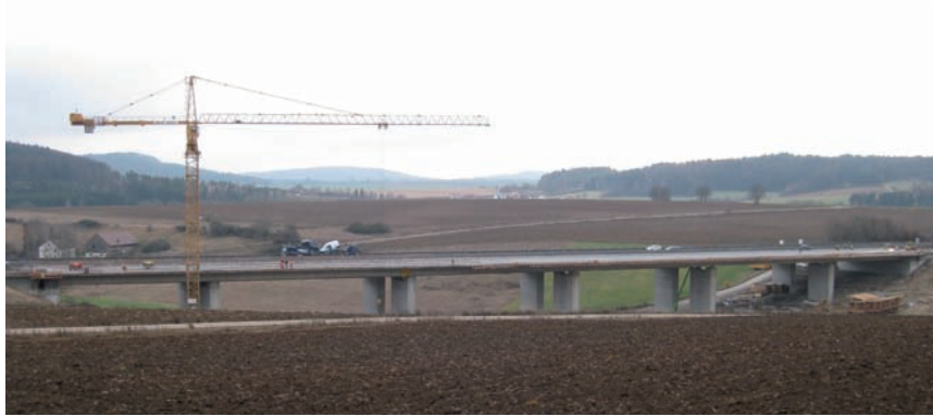
Bild 1.7: Talbrücke Schallermühle im Zuge der A 3, Foto: ABD Nordbayern
