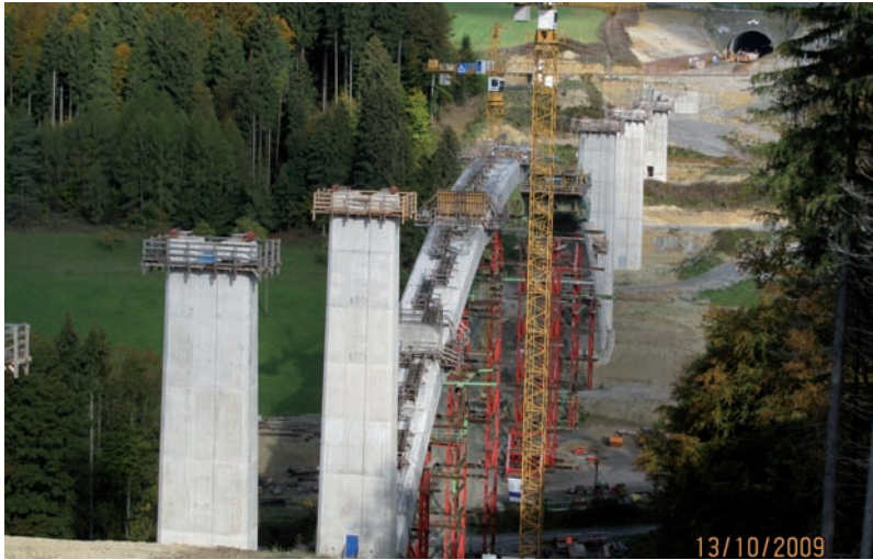
Bild 1.20: Truckenthalbrücke im Zuge der NBS Ebensfeld - Erfurt, Übersicht, Foto: DB ProjektBau
