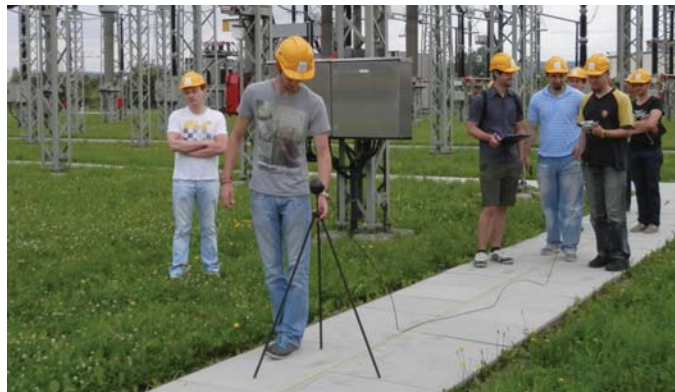
STUDENTEN BEI DER MESSUNG DER ELEKTRISCHEN FELDSTÄRKE E IN DER 380-KV-SCHALTANLAGE DES UW DRESDEN SÜD
