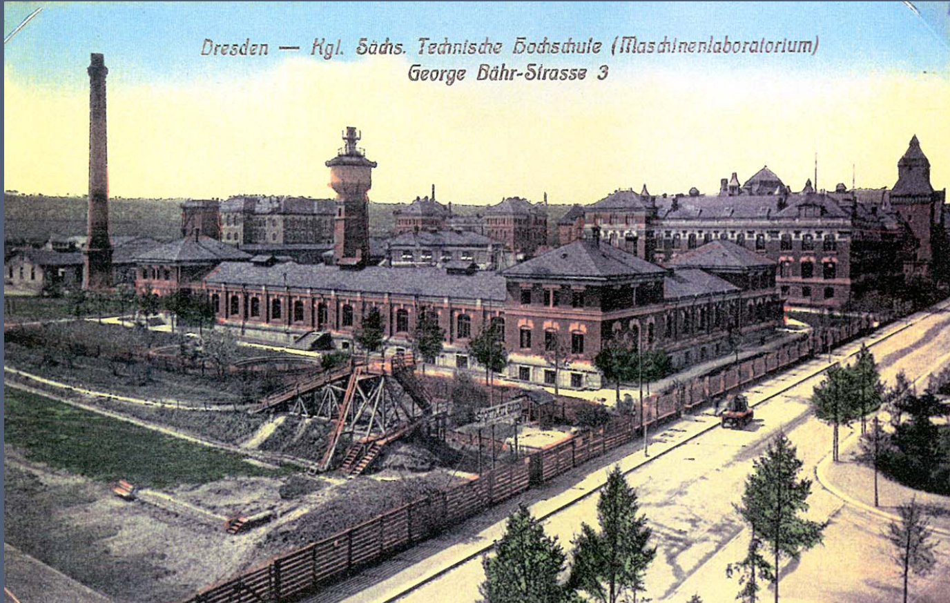
Maschinenlaboratorium, Hauptseminargebäude, Mechanisch-Technische Versuchsanstalt, Elektrotechnisches Institut, Elektrizitäts- und Heizwerk
