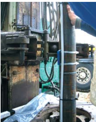
Sondenrohr mit Temperaturmeßkabel (Fotos: Hamann)
