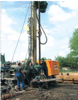
Bohranlage für Geothermiebohrung
