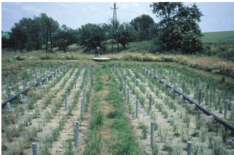
Abb. 1: Vertikal durchflossenes Pflanzenbeet mit über dem Boden liegenden Abwasserverteilungssystem
