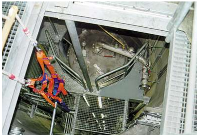
Abbildung 2: Blick in den Schacht der Forschungsanlage Bitterfeld
