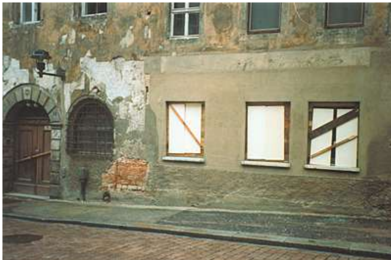
Stark kontaminiertes Wohnhaus in Meißen
