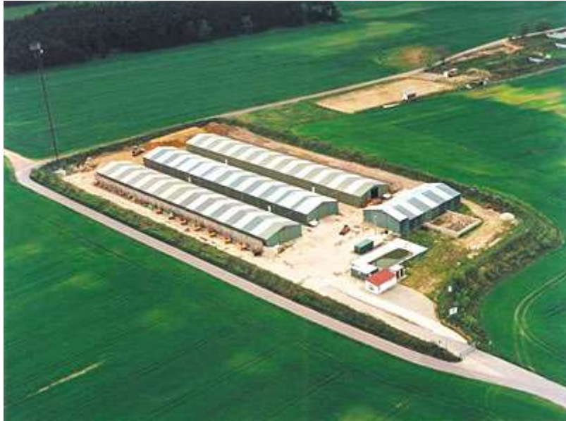
Blick auf die Bodensanierungsanlage "Schildau"
