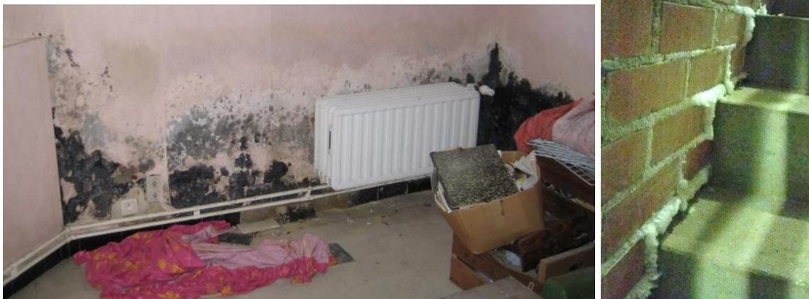
**Abbildung 1: Schadensbilder für aufsteigende Feuchte (links) und Salze (rechts)**
