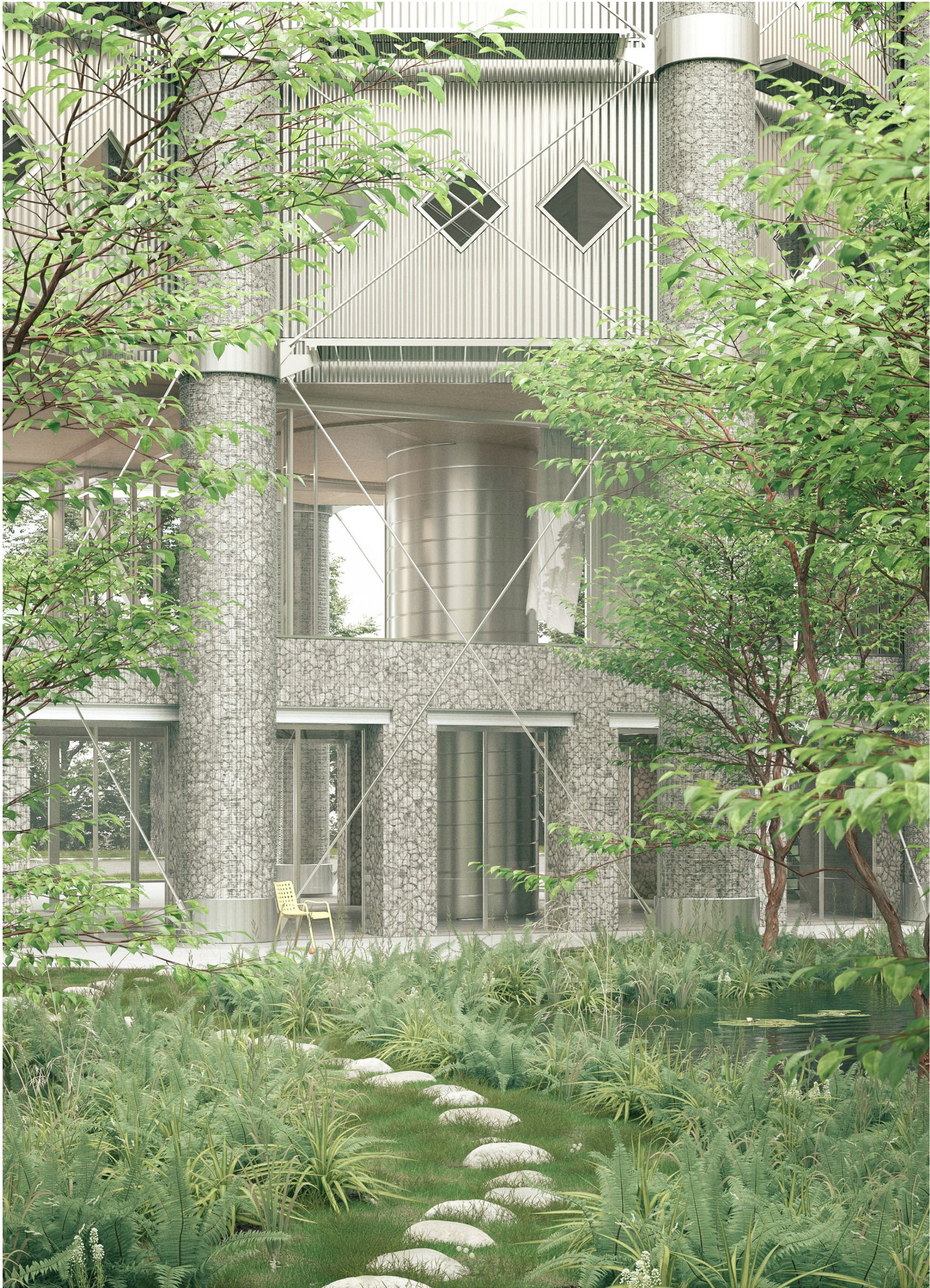
Reinigung Kanalwasser durch Biologische Filterbecken
