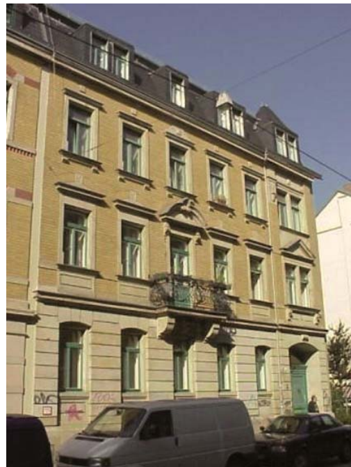
Abb. 1: Denkmalgeschütztes Wohngebäude in Dresden - Fallbeispiel für die Gruppe der mehrgeschossigen Gründerzeitbauten in Blockrandbebauung
