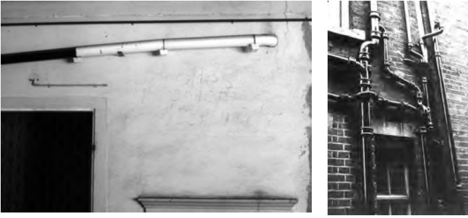
Abb. 4, 5. Nachrüstung mit Gebäudetechnik: Barockhaus in Pirna und klassizistisches Wohnhaus in Edinburgh
