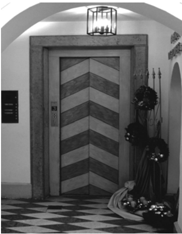
Abb. 9. Illusionistische Verkleidung: Moderne Bautechnik hinter motivischen Resten des Mittelalters: „gotischer“ Fahrstuhl, Am Platzl, München.
