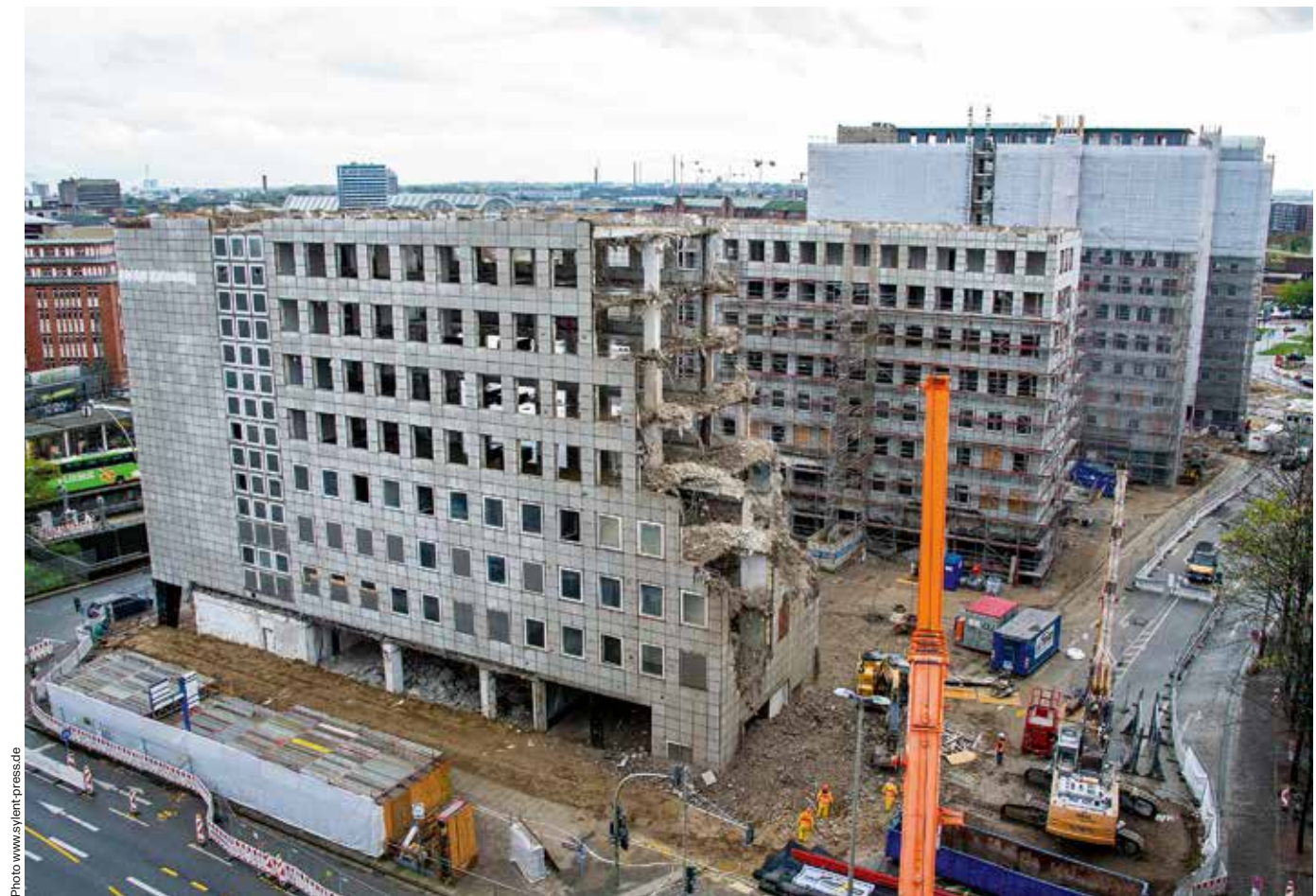
A sinistra: dopo il trasferimento degli uffici comunali di Hamburg-Mitte nel maggio 2017, il complesso del City-Hof di Amburgo è rimasto vuoto in vista della riqualificazione dell'area. Nel marzo 2018 è stata concessa l'autorizzazione alla demolizione dell'insediamento edilizio, avviata nell'aprile 2019 Left: when the district offices of Hamburg-Mitte were transferred in May 2017, the City-Hof was left empty, awaiting local regeneration. Permission to demolish the complex was granted in March 2018 and the work commenced in April 2019
