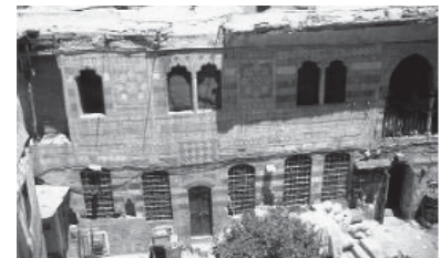
Abb.3 Bayt al-Hawraniya, Guwwani, Fassade der Qaa
