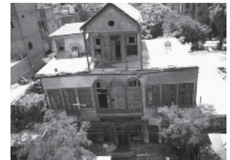
Abb.12 Bayt Gabri, Ansicht Straßenfassade
