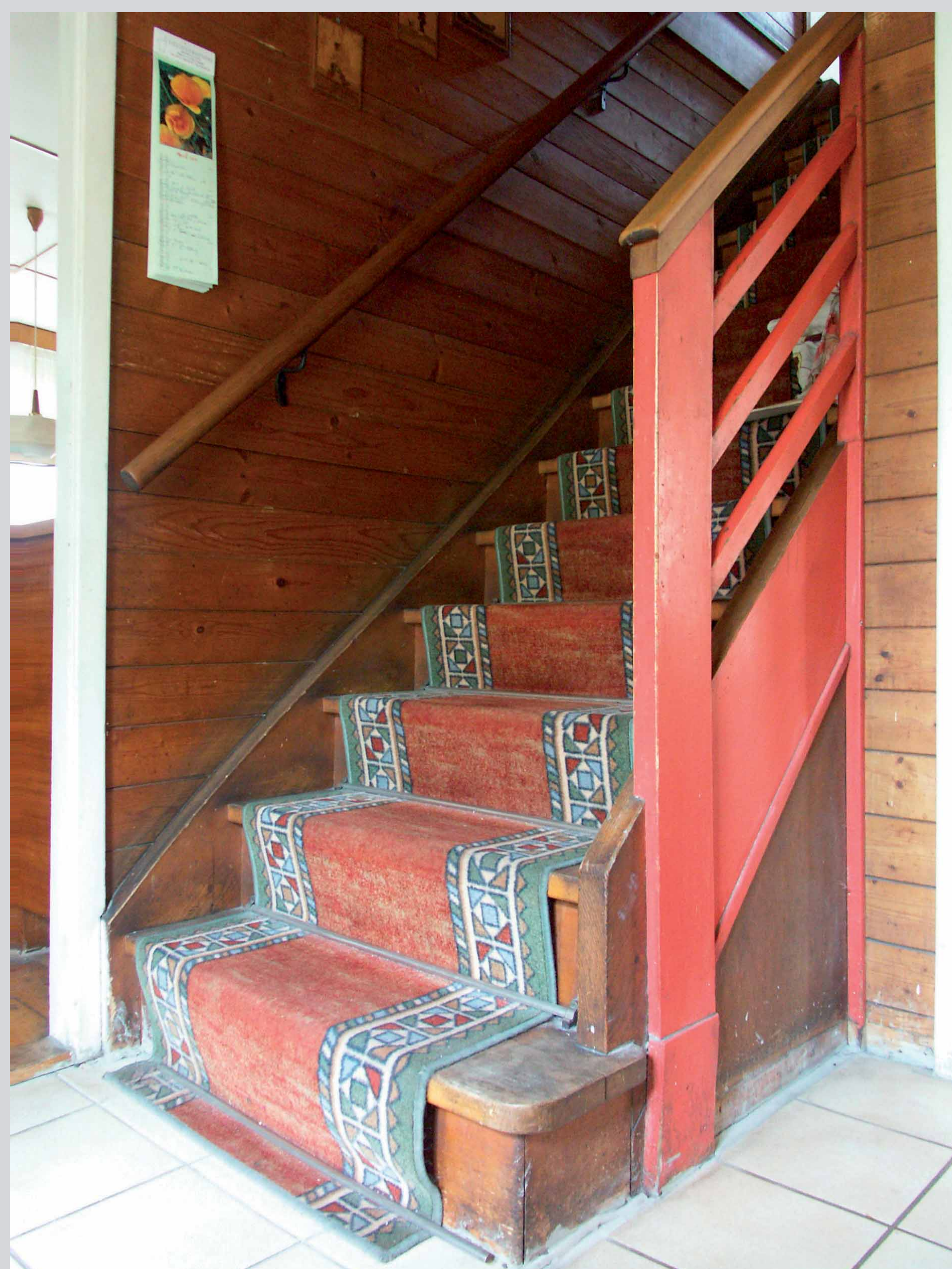
Links: Am Sonnenhang 3. Eingangsbereich. Holztreppe mit originalem Geländer und Handlauf, Farbfassung „Hellerauer Rot“. Oben: Detail der Läuferbefestigung.
