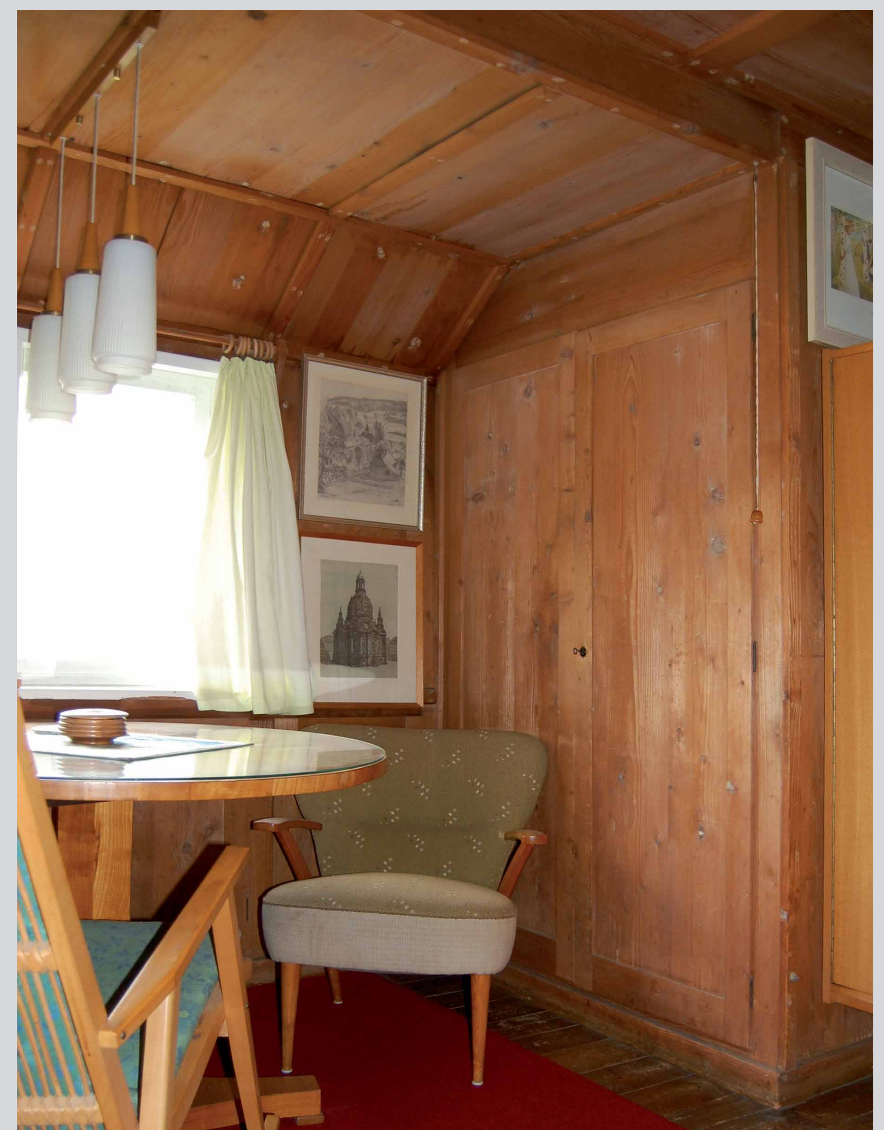
Links: Fabrikationshalle für Holzhäuser um 1925, Innenansicht. Unten: Aufbau der Innenwand und Decke durch Sperrholzplatten, Verblendung der Stöße mit Holzleisten. Die eingepassten Wandschränke bieten neben Stauraum auch eine gewisse Dämmung.
