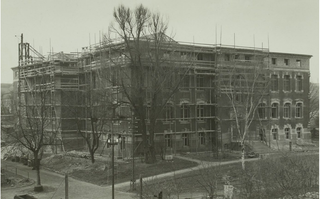
Abb. 11 Wiederaufbau des Görges-Baus (Unbekannt 1949)
