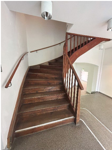
Abb. 25 Treppe 3 – Holztreppe (Alexa-Joelina Mammitzsch 2023)
