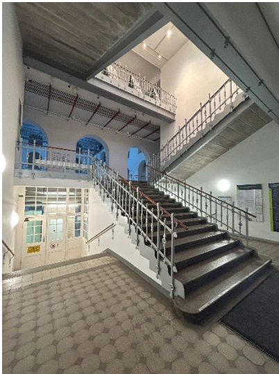
Abb. 7 Haupttreppe (Alexa-Joelina Mammitzsch 2023)
