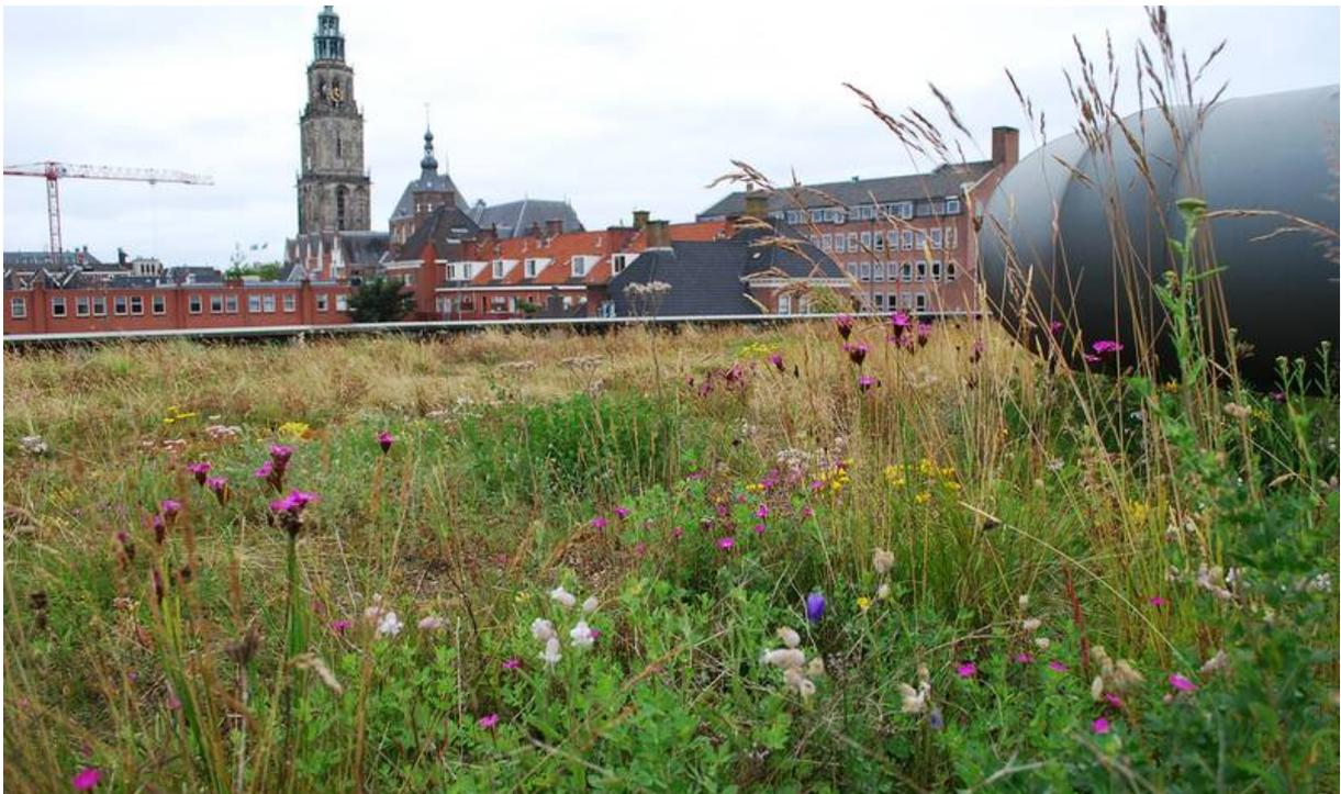
Abb.4: Fotografie Einfache Intensivbegrünung, Quelle: [https://www.optigruen.de/fileadmin/\\_processed\\_/5/5/csm\\_RD\\_2-1\\_5c2e546621.jpg](https://www.optigruen.de/fileadmin/_processed_/5/5/csm_RD_2-1_5c2e546621.jpg) (Aufgerufen:29.06.2022).
