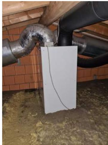
Abbildung 2-10: Lüftungsanlage für Außenluftwechsel im benachbarten Kaltdachbereich.
