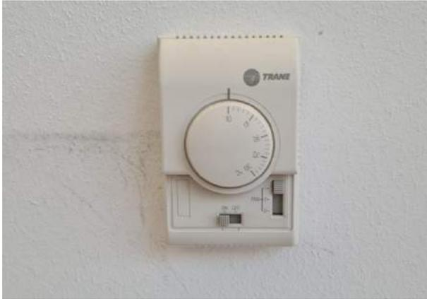
Abbildung 2-8: Regelung für die Lüftungsanlage
