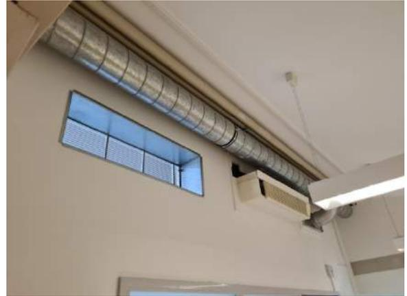
Abbildung 2-9: Zuluftkanal (Wickelblechrohr) und Überströmöffnung (verzinktes Lüftungsgitter) für Umluftkälteaggregat
