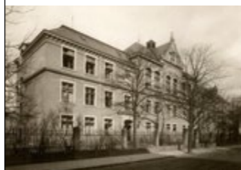
9 Bürgerschule Blasewitz (Erweiterungsbau), 1900/01 Wagnerstraße 26 (früher Schulstraße)
