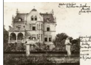
14 Villa von Borcken, 1894/95 Tolkewitzer Straße 47
