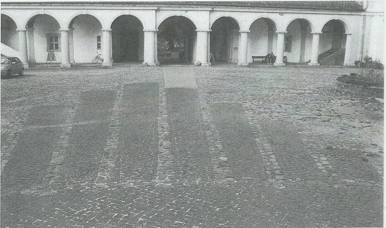
92 Neuzelle (Landkreis Oder-Spree), Strahlenmuster vor dem Portal der Klosterkirche (Kombination aus Lesesteinpflaster und Kleinsteinpflaster, 1926 verlegt).
