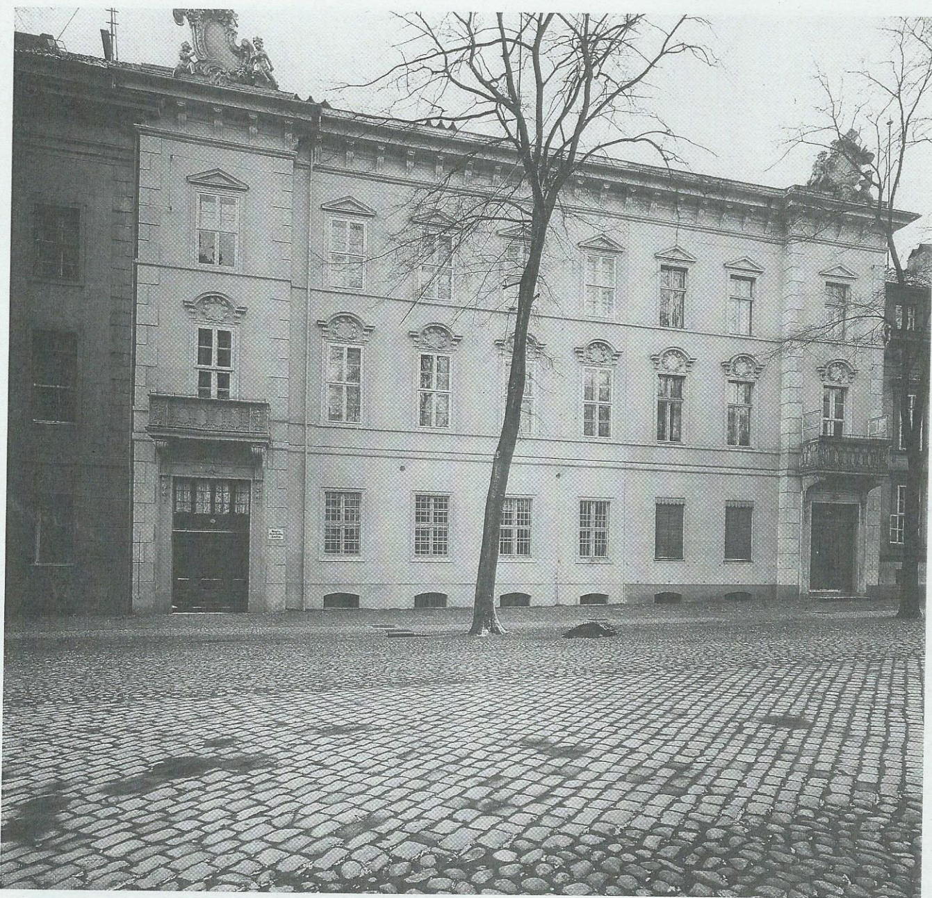
88 Potsdam, Breite Straße 28-29; Aufnahme 1912. Lesesteinpflasterung mit Fahrspur aus diagonalem Reihenpflaster in der Mitte, dessen Anschluß ohne spezielle Paßsteine erfolgte. Im Bereich des Gehwegs zeichnet sich ein heller, mit ausgesuchtem Material belegter Laufstreifen ab.
