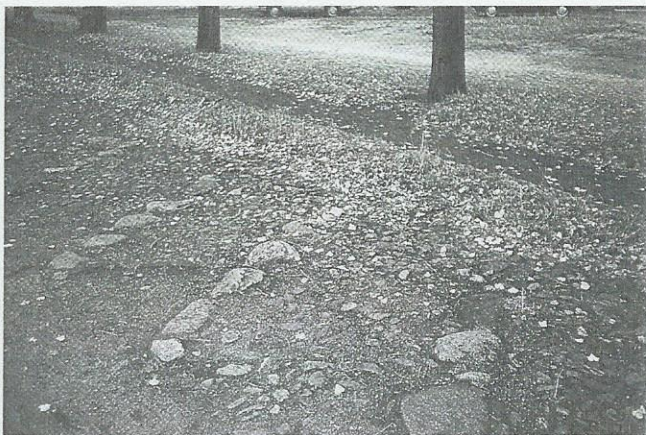
81 Neuzelle (Landkreis Oder-Spree), Gurtbänder in dem vor 1840 entstandenen Lesesteinpflaster des ehemaligen Klosterhofs; Aufnahme 1999.
