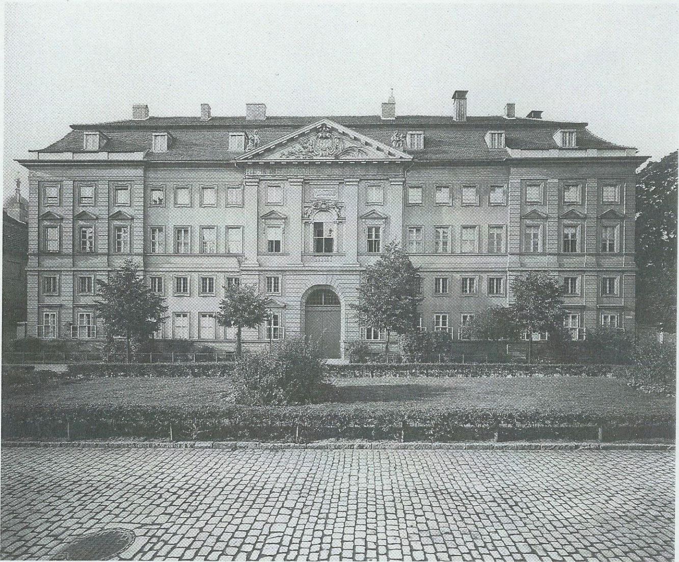
86 Potsdam, Militärwaisenhaus, Front an der Breiten Straße; Aufnahme 1912. Die Straße zeigt ein in Reihe verlegtes Großsteinpflaster. Der runde Kanaldeckel wurde mit Spezialsteinen rechteckig eingefasst, um die Spannung im Verband nicht zu schwächen.
