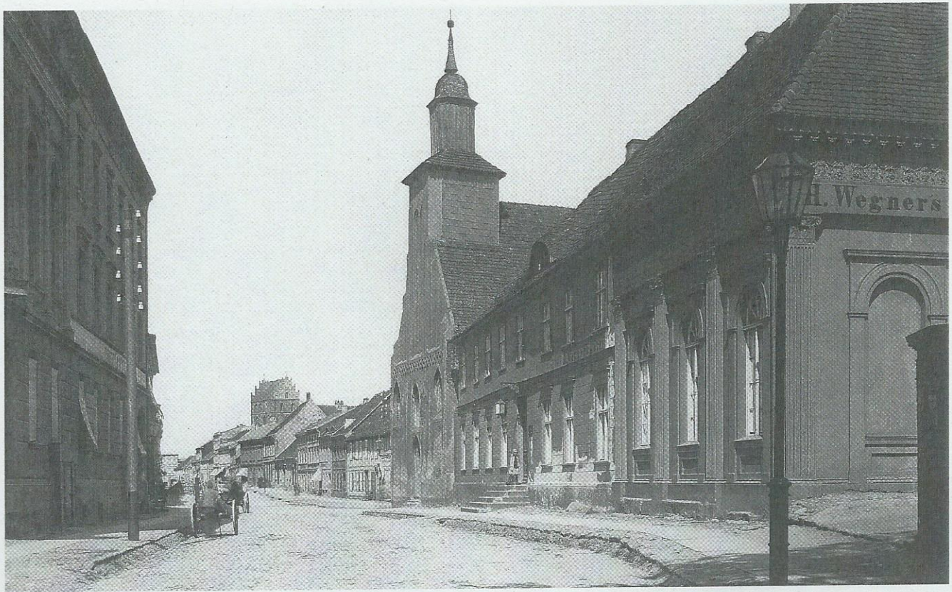
▼ 85 Brandenburg an der Havel, Blick auf das Paulikloster; Aufnahme 1895. In der mit Lesesteinen gepflasterten Temnitzstraße verläuft in der Mitte eine Fahrspur aus in unregelmäßigem Verband verlegtem Bruchsteinmaterial. Die ausgepflasterte Gasse vor den Hauseingängen ist mit Holzbohlen überbrückt.
