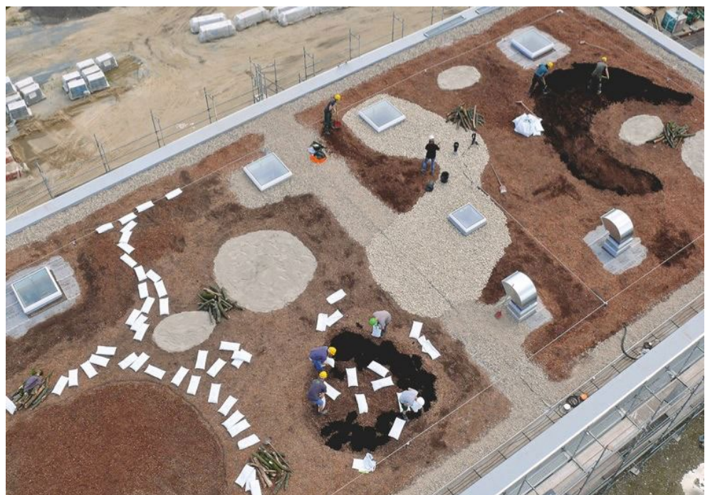
ABB. 70. BIODIVERSITÄTSMODULE AUF DEM IGA BERLIN-BESUCHERZENTRUM-DACH
