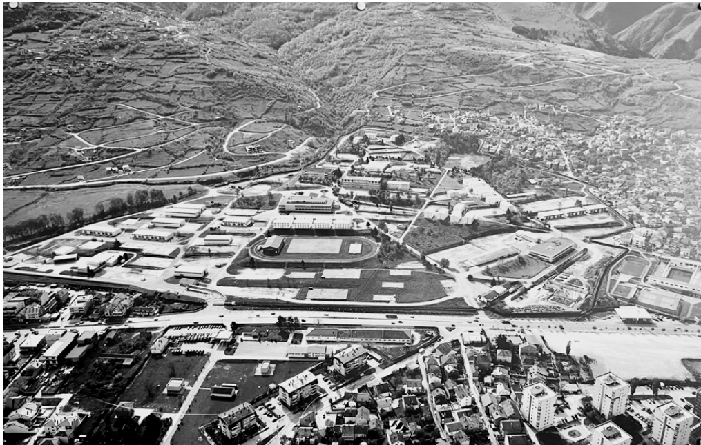
Abb. 3: Schrägluftbild ehemalige KFOR Kaserne Prizren (Kosovo)
