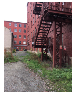
Ehemalige Fabriken und Bestandsgebäude
