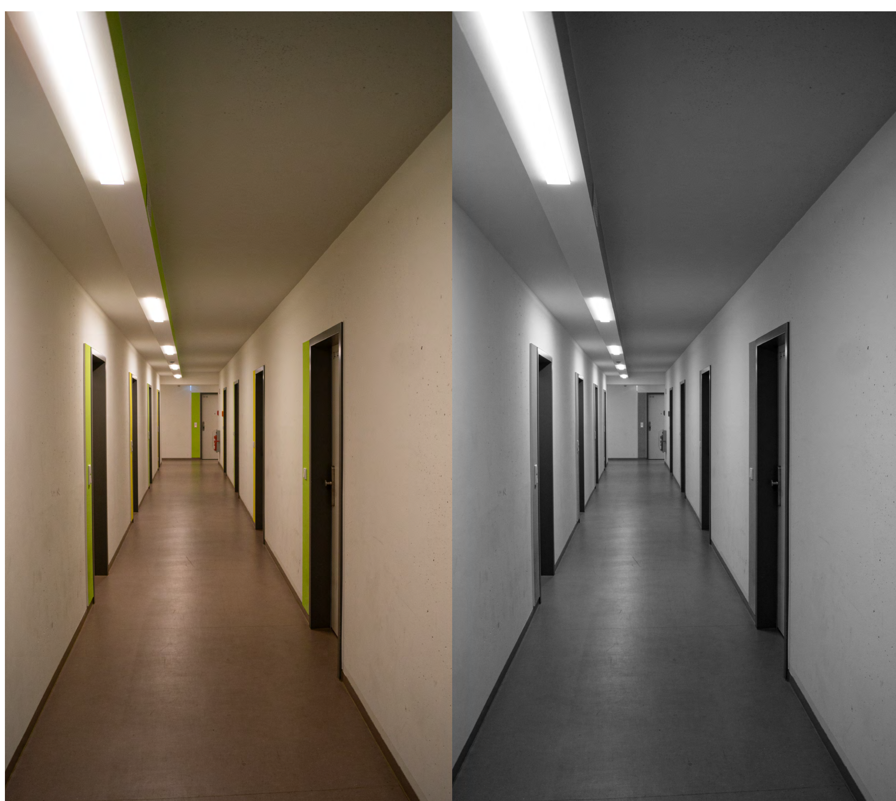
Abb. 2: Wohnheimflur Gret-Palucca-Straße 11: Visuell kontrastierende Gestaltung von Boden, Türzargen, Ausstattung- und Bedienelementen. Unterstützende Beleuchtung in Laufrichtung. Schwarz-Weiß-Abbildung zeigt den Leuchtdichtkontrast.
