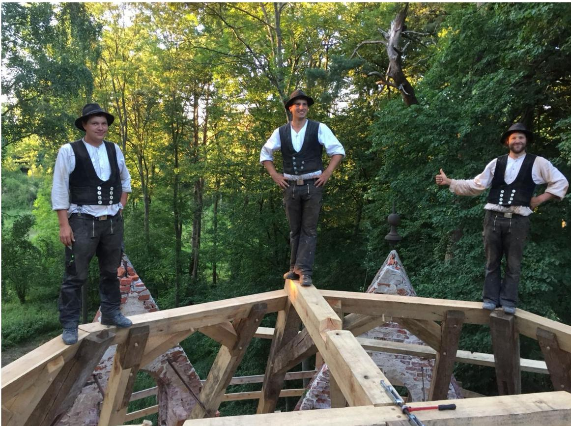
Bild 5 „Probelastung des Binderkranzes“ (Paul Neumann, Jäger Ingenieure GmbH, 2018)
