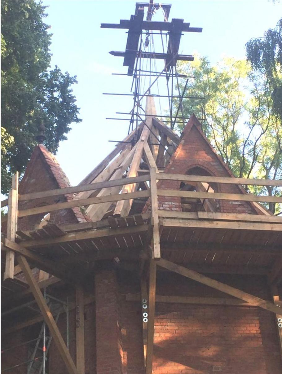
Bild 6 Die Hauptdachkonstruktion steht (Paul Neumann, Jäger Ingenieure GmbH, 2018)
