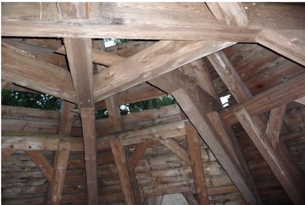
Blick in den Dachstuhl Ende 2015
