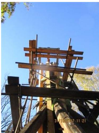
Gerüst für die Kugel
