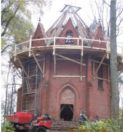
Der Dachstuhl ohne Schalung
