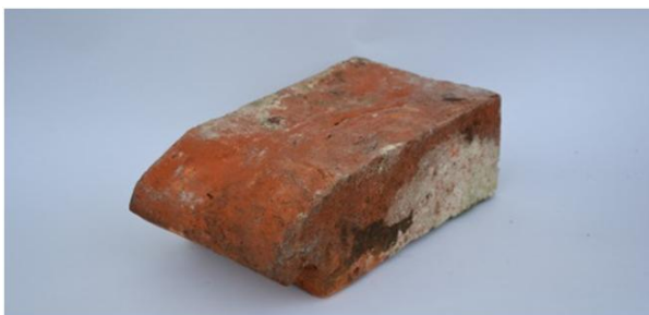
Profiliertes Simstein – von dieser Sorte müssen eine ganze Menge nachgebrannt werden
