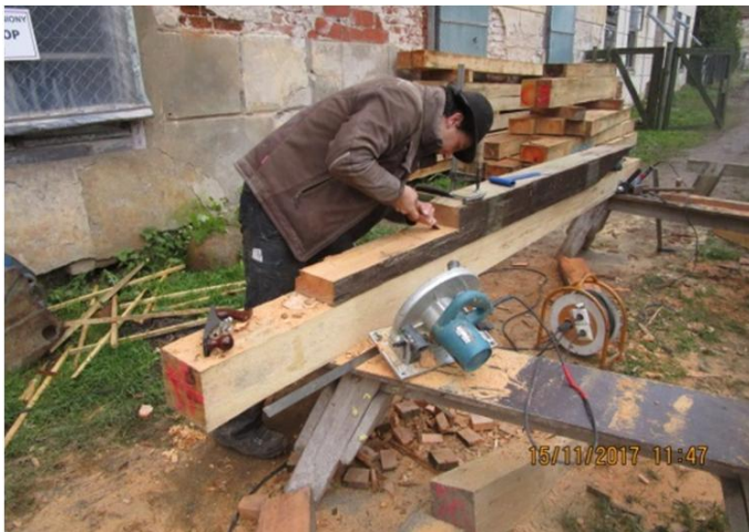
Zimmerer Malte Urban beim Ausarbeiten eines stehenden Blattes
