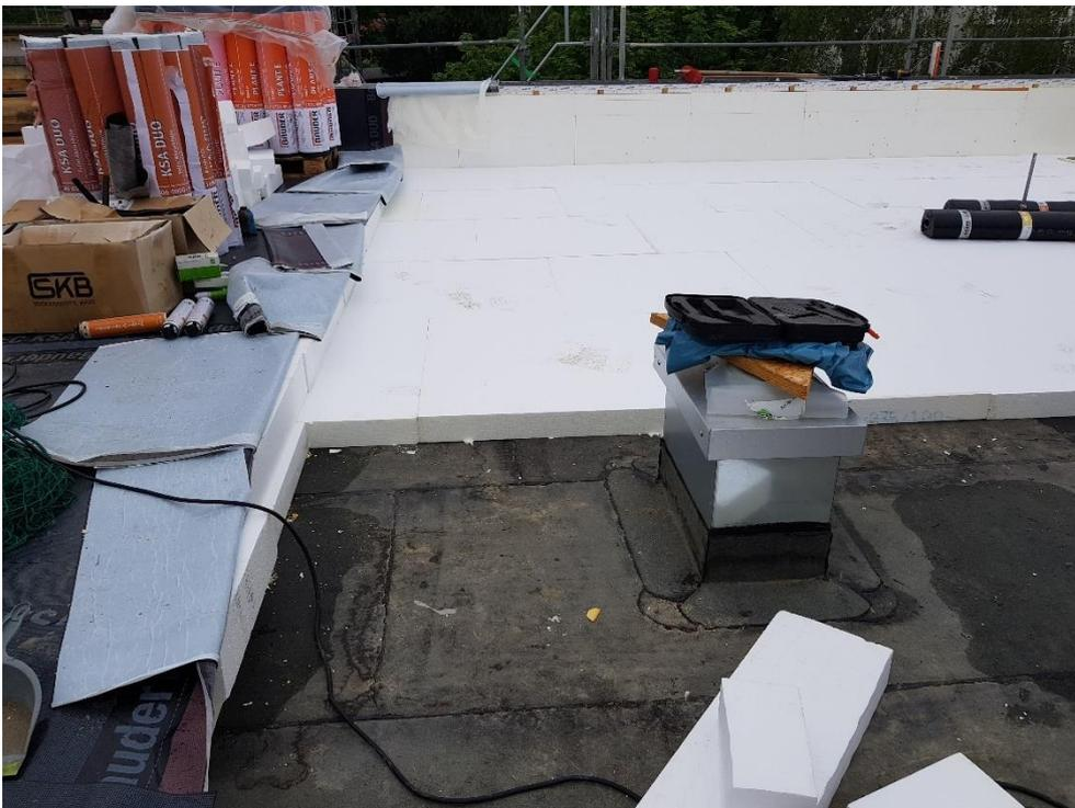
Abb. 13 Zwischenlagerung von Material und Verbau der Dämmplatten, Dachdecker Dittrich Baustelle Thymianweg in Dresden<sup>13</sup>
