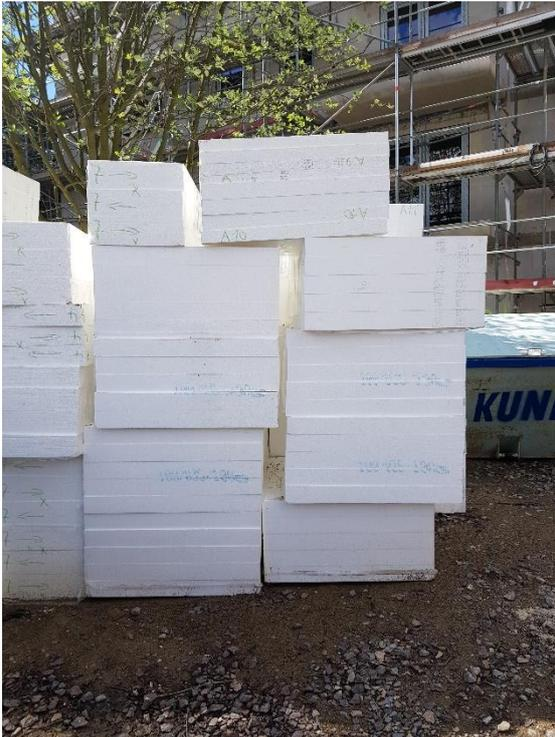
Abb. 12 Lagerung von EPS-Dämmplatten, Dachdecker Dittrich Baustelle Thymianweg in Dresden<sup>12</sup>
