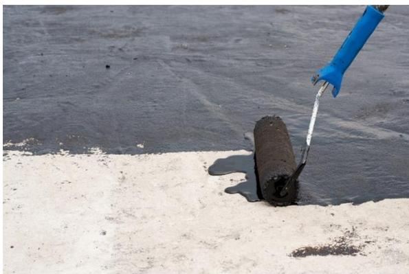
Abb. 11 Verarbeitung von Haftbrücke mit Farbrolle<sup>11</sup>
