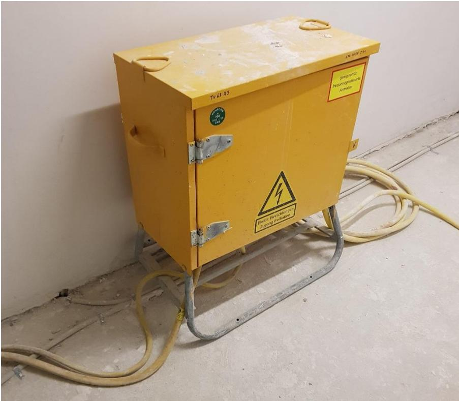
Abb. 5 Stromkasten, Züblin Baustelle Dessauer Straße in Leipzig<sup>5</sup>
