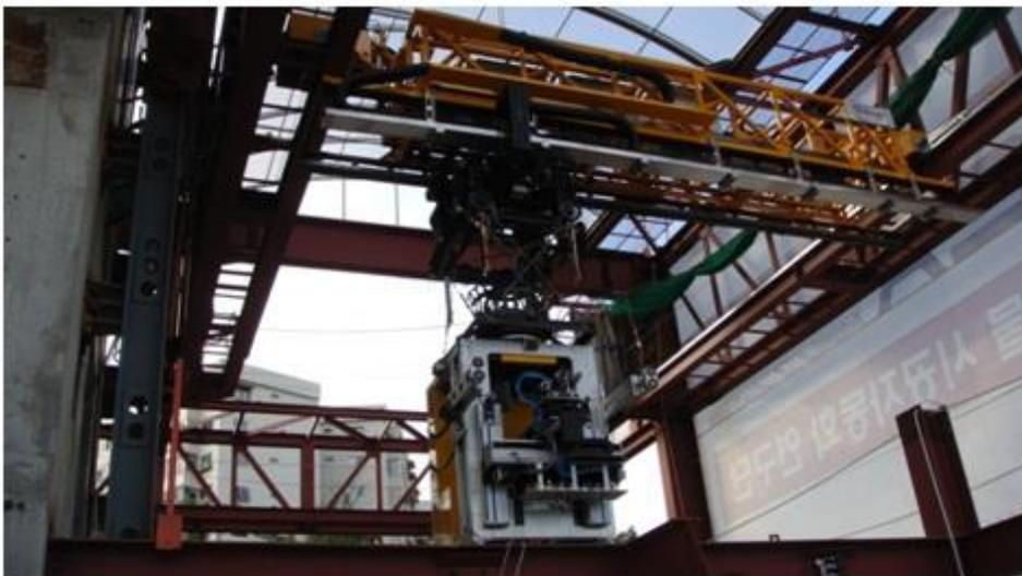
Abbildung 6 Schraubroboter auf Schienen<sup>6</sup>
