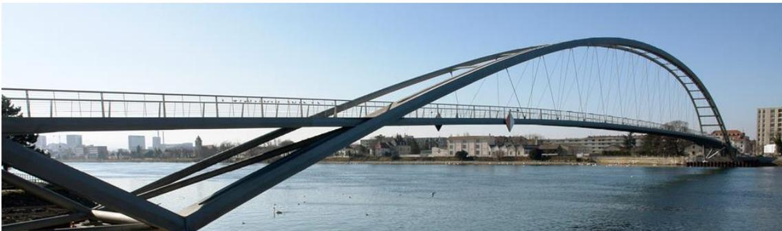
Abbildung 10: Dreiländerbrücke; Bogenbrücke mit abgehängtem Fahrbahntragwerk
