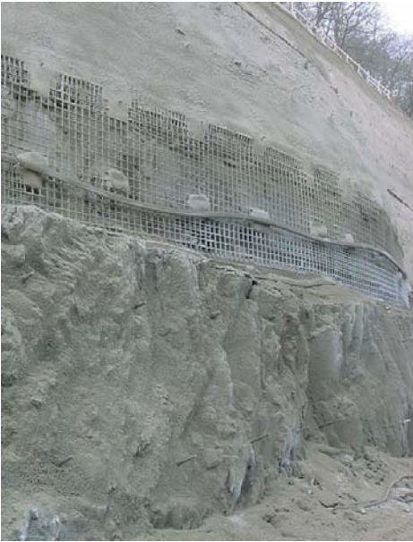
Bild 5 : Steilböschung im Fels
