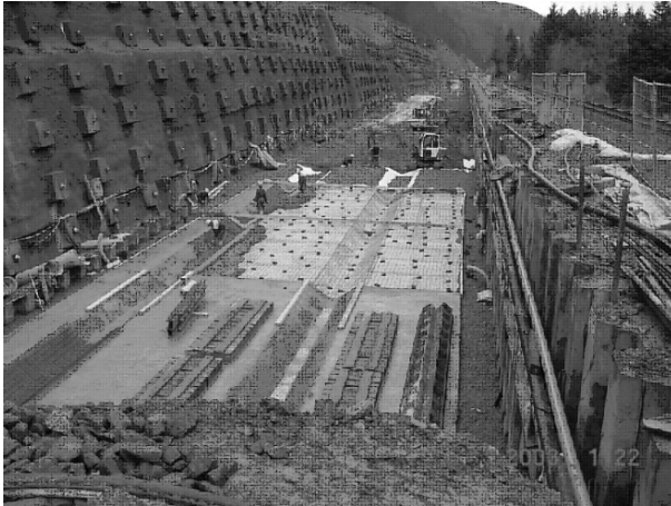
Bild 18 : Herstellung der Schubnocken (Unterbau)
