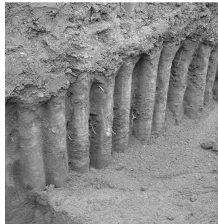
Bild 8 : Stabverpresspfähle zur Sicherung des Bimssandes
