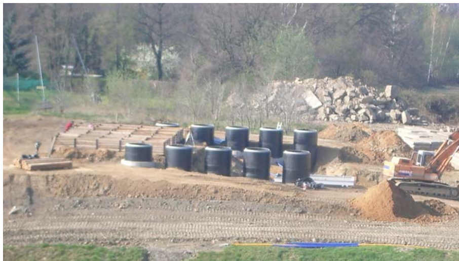
Abbildung 2: Lysimeteranlage Bautzen/Nadelwitz zur Untersuchung von Wasserhaushaltsschichten
