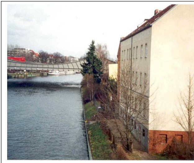
Abb. 4: Ufernahe mehrgeschossige Bebauung an der UHW
