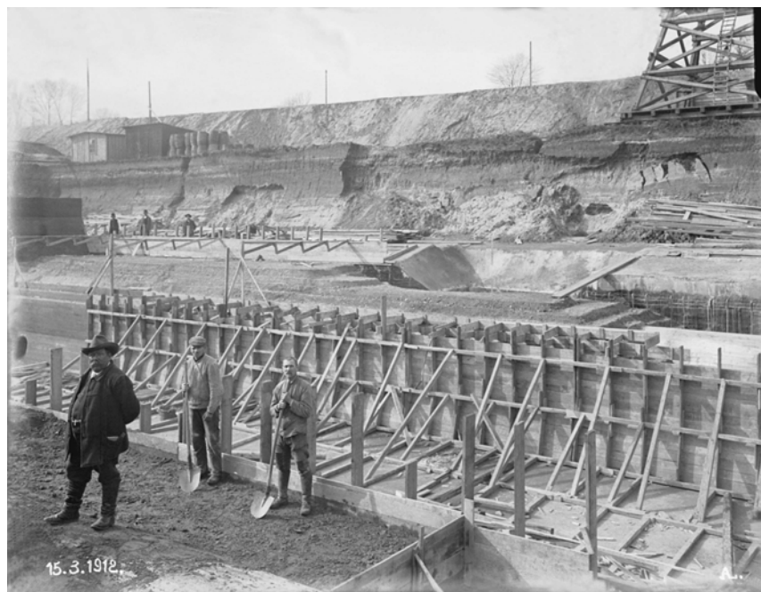
Abbildung 3: Fotografie der Baugrubenböschung beim Bau der Schachtschleuse (1913)
