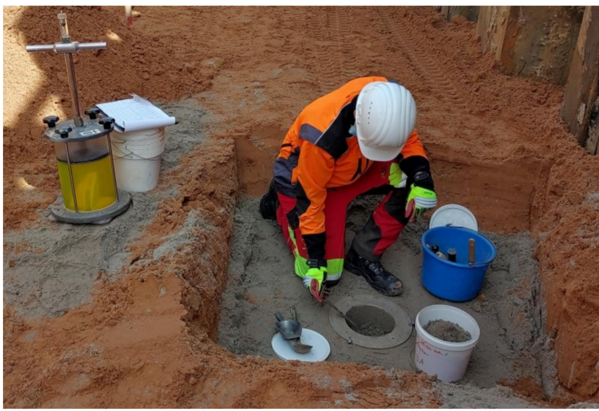
Abb. 1: Dichtebestimmung im Feld mit dem Ersatzverfahren (Ballongerät); Baustellenfoto: C.Eichholz
