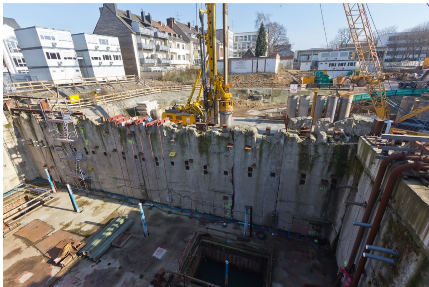
Abb. 1: fertiggestellte Schlitzwand.
