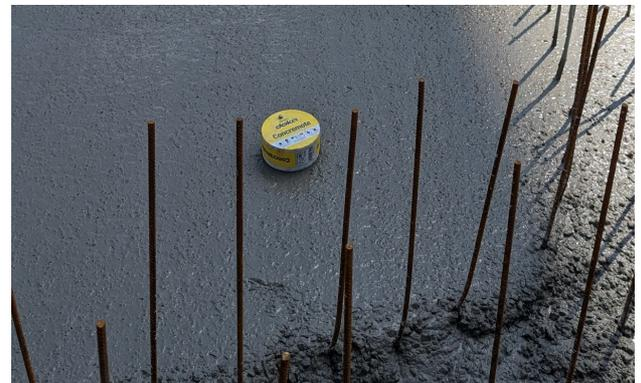
Abb.: Deckensensor zur Temperaturbestimmung
