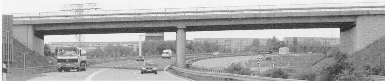
Bild 4. Ansicht Referenzbauwerk im Kreuzungsbereich B 156/BAB A 4 in Bautzen Fig. 4. Side view of the reference building at the road junction B 156/BAB A 4 in Bautzen
