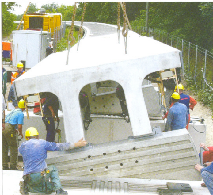
Bild 6: Einbau des Prototyps für den Fahrwegträger System Bögl
