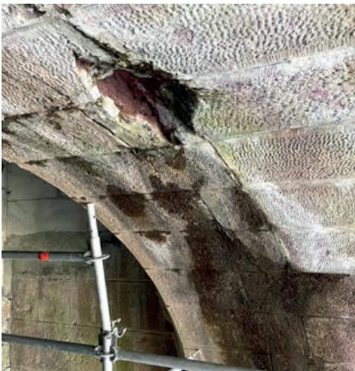
Längsrisse auf der Gewölbeinnenseite bei der Brücke Tälesbach | Longitudinal cracks on the inner side of the arch of Tälesbach bridge | Photo: Conrad Pelka
