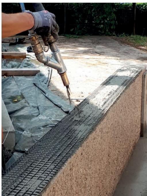
Verstärkung eines Plattenbalkens mit textiler Carbonbewehrung für einen Laborversuch | *Strengthening of a T-beam with textile carbon reinforcement for a laboratory test* | Photo: Sebastian May
