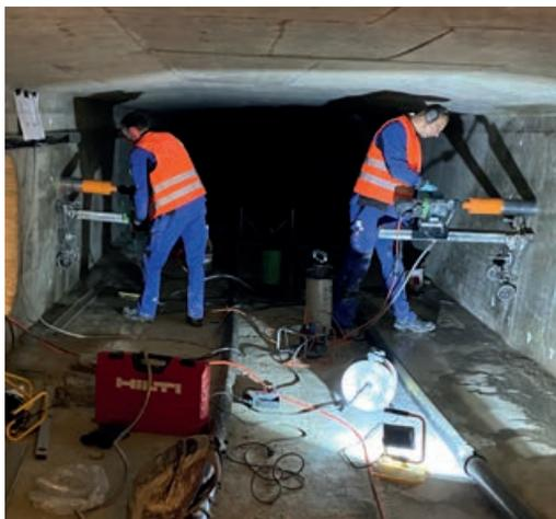
Bohrkernentnahme im Hohlkasten des Bestandsbauwerks | Drill core extraction in the hollow box of the existing structure | Photo: Peter Betz
