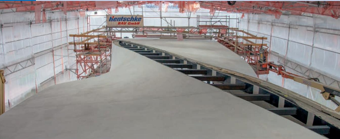
Die verwundenen Dach-Wand-Schalen TWIST des Carbonbetongebäudes CUBE im Bauzustand | *The twisted roof-wall shells TWIST of the carbon reinforced concrete building CUBE under construction* | Photo: Stefan Gröschel
