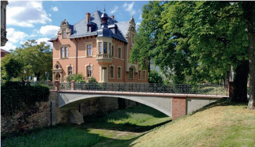
Die mit Carbonbeton verstärkte Brücke Thainburg | Foto: CARBOCON GmbH
