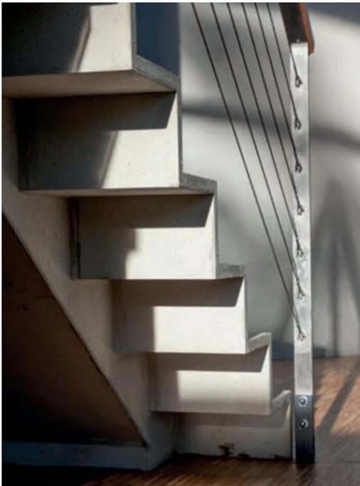
Carbonbetontreppe im Innern des CUBE | Carbon reinforced concrete staircase inside the CUBE | Photo: Stefan Gröschel
