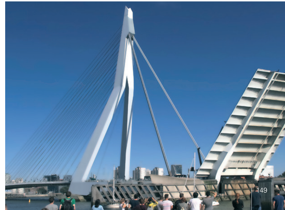
Erasmusbrücke in Rotterdam | Foto: Oliver Steinbock
