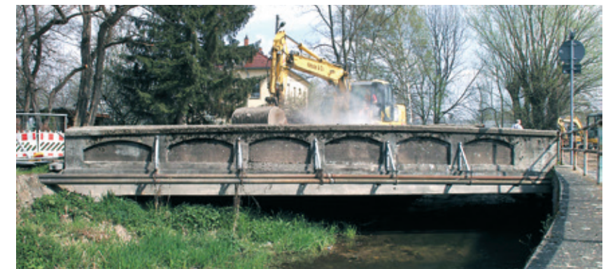
Ansicht der Brücke aus dem Jahre 1905 bei Beginn der Abbrucharbeiten | Foto: Oliver Steinbock
