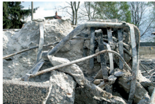
Charakteristische Bewehrung (Flacheisenbügel und aufgebogene Längseisen) der Bauweise Hennebique beim Abbruch einer Brücke in Dresden-Niedersedlitz | Foto: Oliver Steinbock
