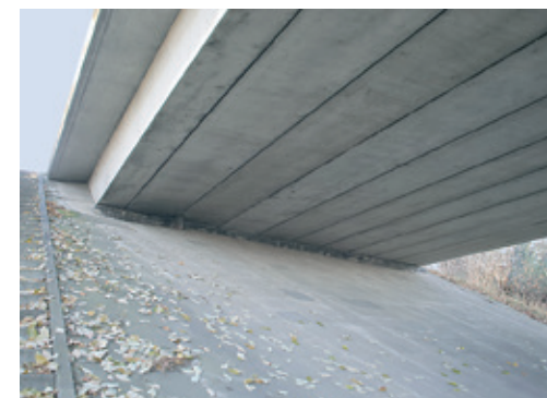
Untersicht einer 4-feldrigen Balkenreihenbrücke über die BAB A14 zwischen Wendischbora und Nossen (SÜ K8052) | Bottom view of a 4-span superstructure compounded of cellular concrete boxes with shear keys over BAB A14 between Wendischbora and Nossen (SÜ K8052) | Photo: Oliver Steinbock
