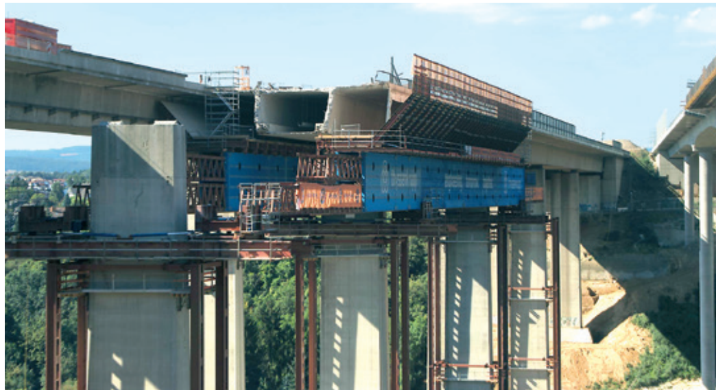
Anwendung einer Vorschubrüstung beim Brückenabbruch der alten Lahntalbrücke | Foto: Oliver Steinbock
