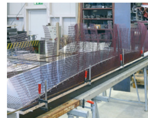
Bogenschalung mit Querkraft- und Zugbewehrung | Formwork with carbon shear and tensile reinforcement | Photo: Sebastian May
