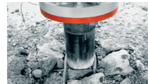
Detailansicht der Schädigung an der Auftreffstelle | Detail of damage state around the impact area | Photo: Tino Kühn
