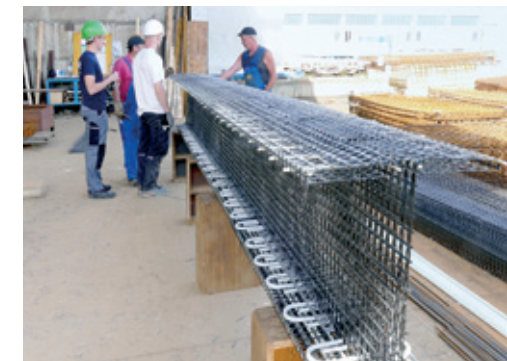
Herstellung des Bewehrungskorbs | Preparation of the reinforcing cage | Photo: Alexander Schumann
