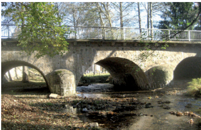
Seitenansicht der Gewölbebrücke | Foto: Elisabeth Plenz
