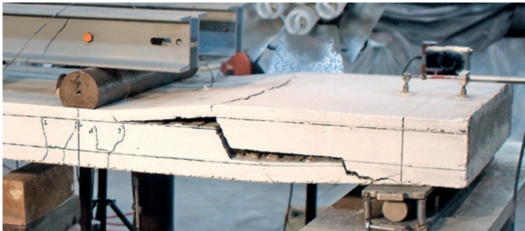
Fugenversagen bei leichten, geschichteten Stahlbetonplatten | Foto: Michael Frenzel
