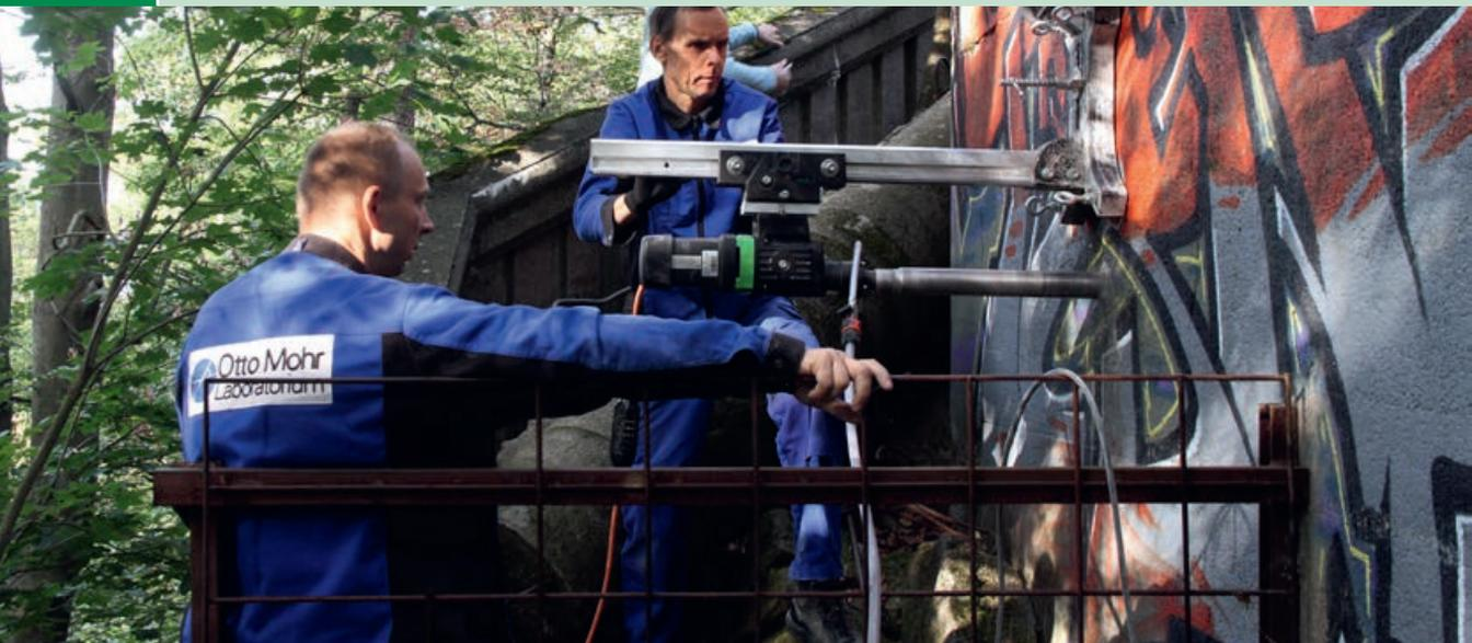
Entnahme von Bohrkernen | Extraction of drilling cores | Photo: Sabine Wellner
