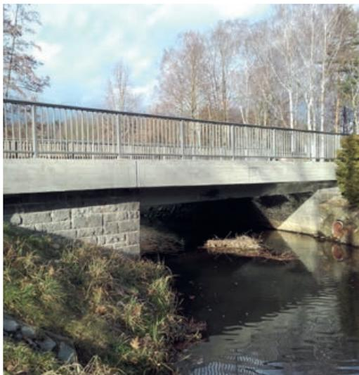
Ausgewähltes Plattentragwerk für die Verstärkungsmaßnahme | Slab for application of carbon reinforced concrete | Photo: Oliver Steinbock
