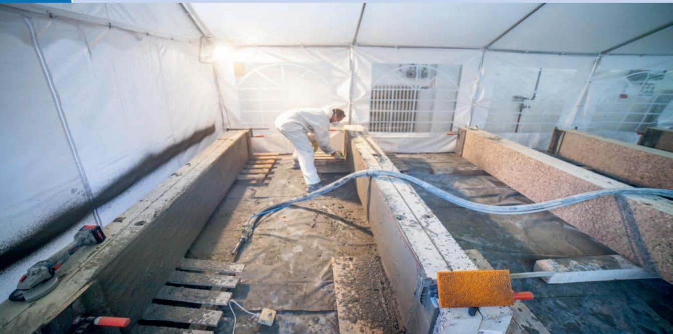
Herstellung biegeverstärkter Stahlbetonplatten mit Carbonbeton | Production of carbon concrete reinforced ceiling elements | Photo: Stefan Gröschel
