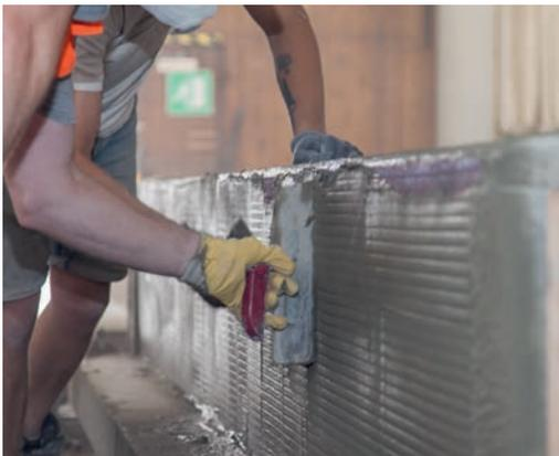
Verstärkung von Plattenbalken mit Carbonbeton | *Strengthening of a steel reinforced concrete beam with carbon reinforced concrete* | Photo: Stefan Gröschel
