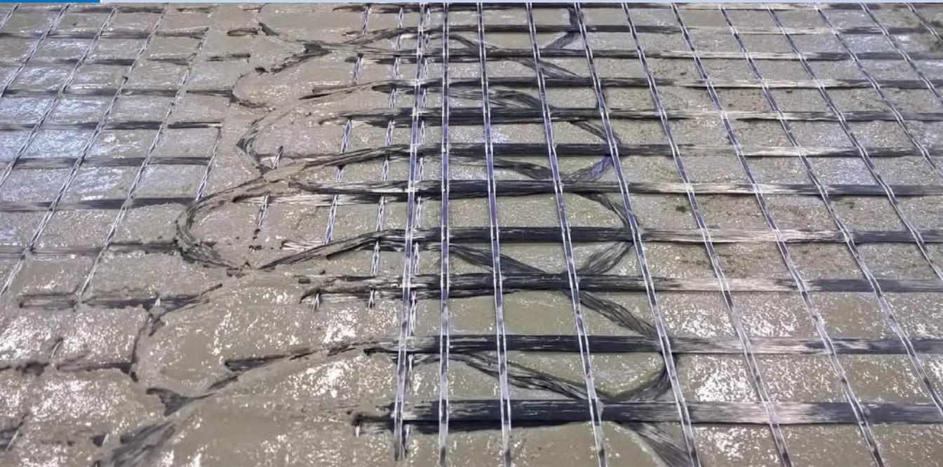
Übergreifungsstoß in der Verstärkungsschicht | *Overlapping area in the strengthening layer* | Photo: Franz Bracklow
