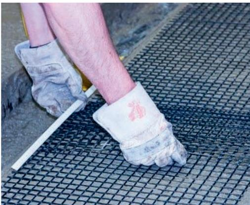
Einsatz von textiler Bewehrung für Brückenkappen | Use of textile reinforcement for bridge caps | Photo: RUB, Lehrstuhl für Baustofftechnik
