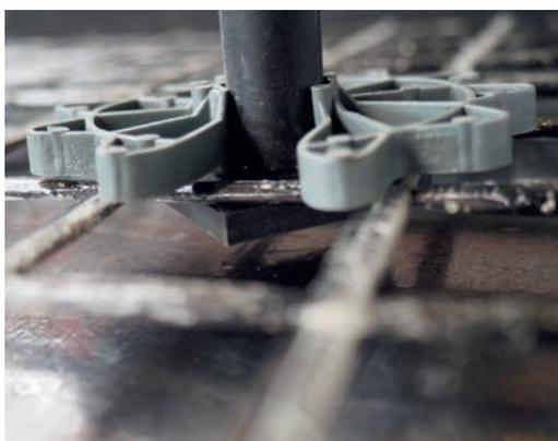
Ein Ende des Thermoankers dient gleichzeitig als Abstandhalter für die textile Bewehrung, eine handelsübliche Klemme kann zur Befestigung genutzt werden | *One end of the thermal anchor can also be utilized as spacer for the textile reinforcement, therefore a commercial clamp can be used as fastening* | Photo: Juliane Wagner
