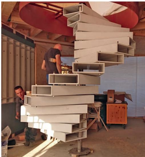
Wand- und Treppenelemente aus Carbonbeton | Wall and stair elements of carbon reinforced concrete | Photo: Marén Kupke (AIB Bautzen)
