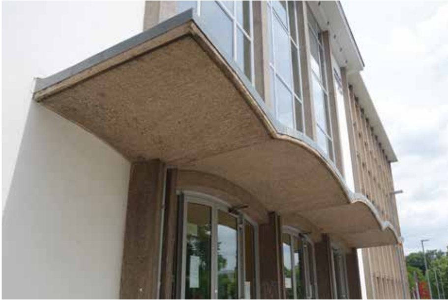
Vordach Andreas-Schubert-Bau, TU Dresden (Foto: Thomas Bösche)
