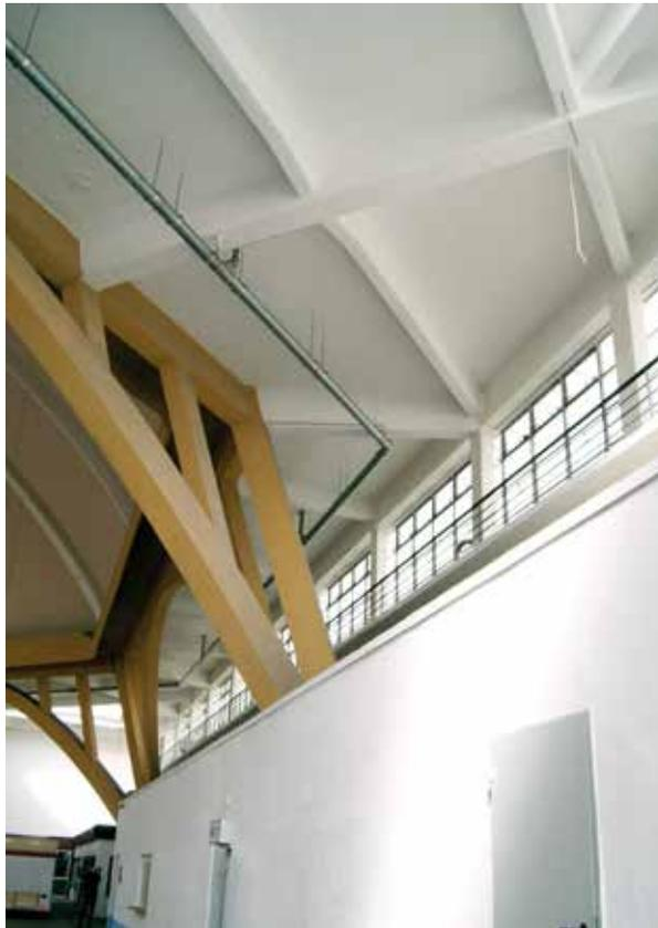
*Untersicht einer Zwickeldecke mit dem Hauptunterzug und den Nebenunterzügen
