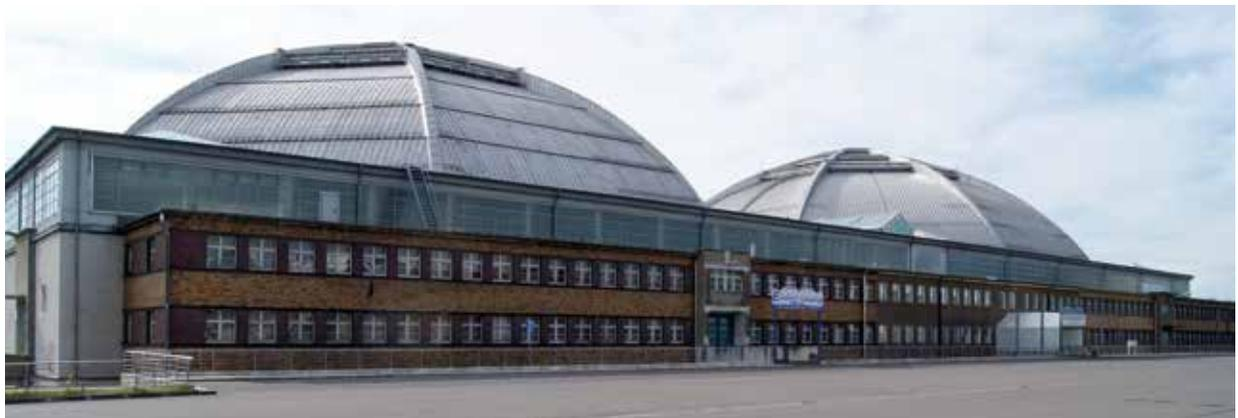
Zweigeschossige Anbauten umschließen die Ost- und Nordseite des Bauwerks. Insbesondere der auf der Ostseite vorgelagerte Bürotrakt betont mit seiner horizontal gegliederten Klinkerfassade nach außen hin die Einheit von Süd- und Nordkuppel.
