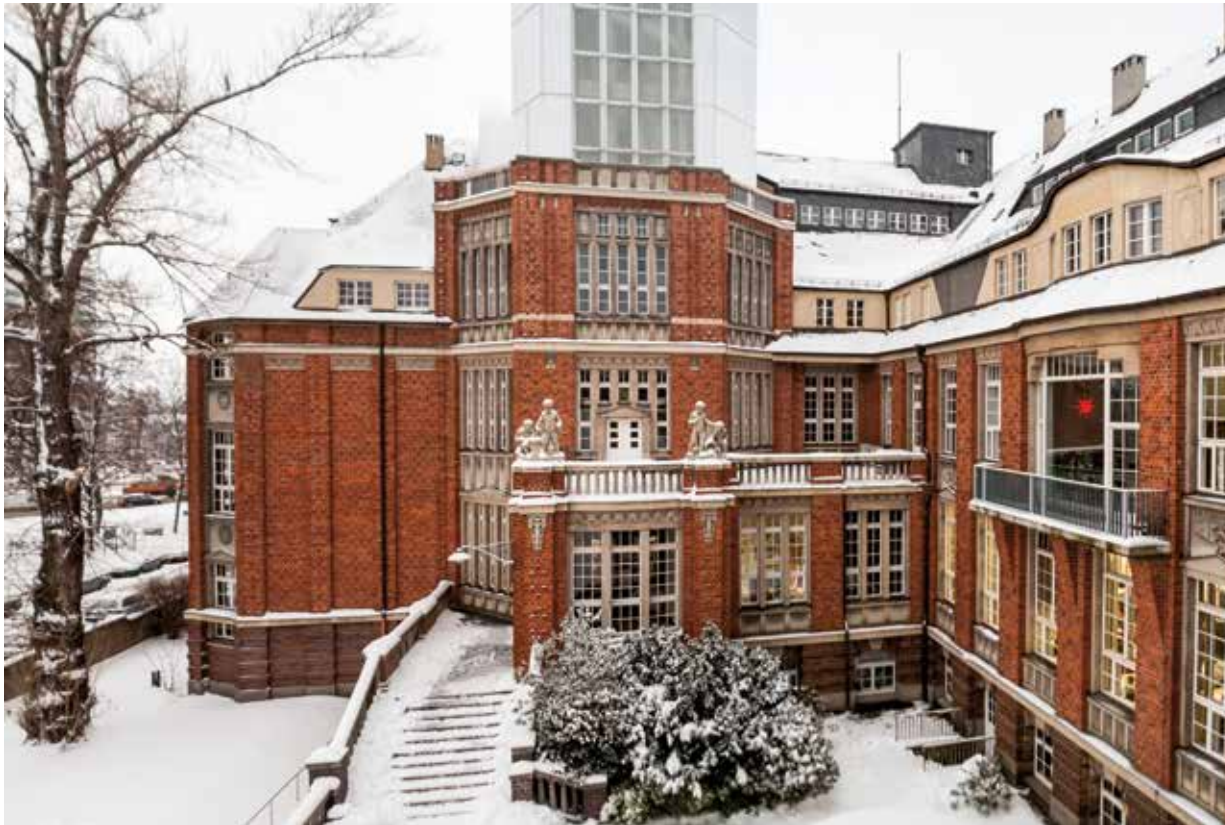
Beyer-Bau Eingangsbereich, Blick aus dem Hörsaal 98
