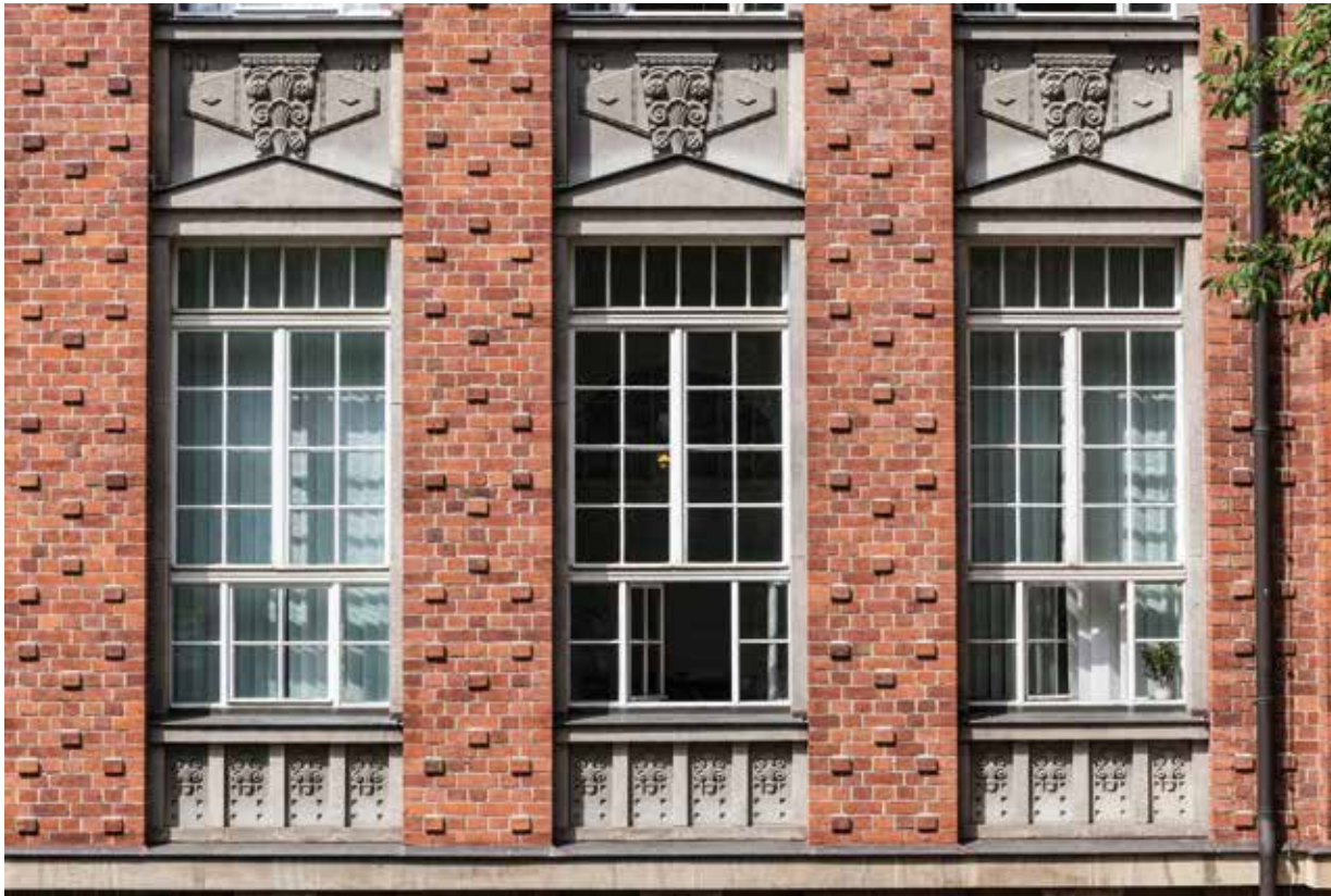
Beyer-Bau Detailansicht Südseite
