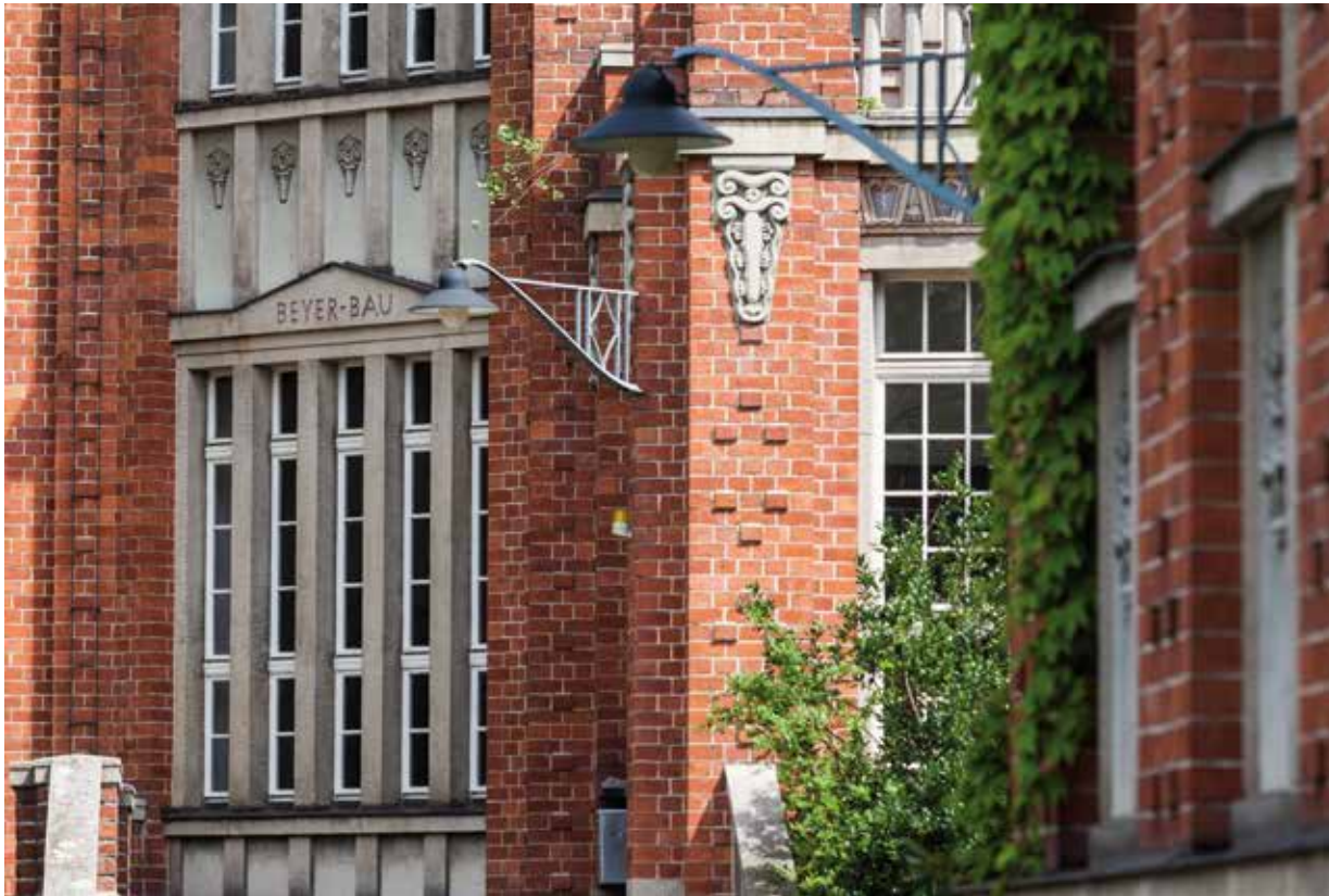
Beyer-Bau Detail Eingangsbereich
