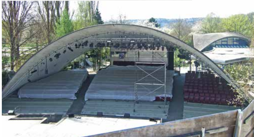
Theater unter den Kuppeln in Leinfelden-Echterdingen, Tragwerksplaner: Heinz Isler, Fertigstellung: 1990 (Foto: Sven Lehmborg)
