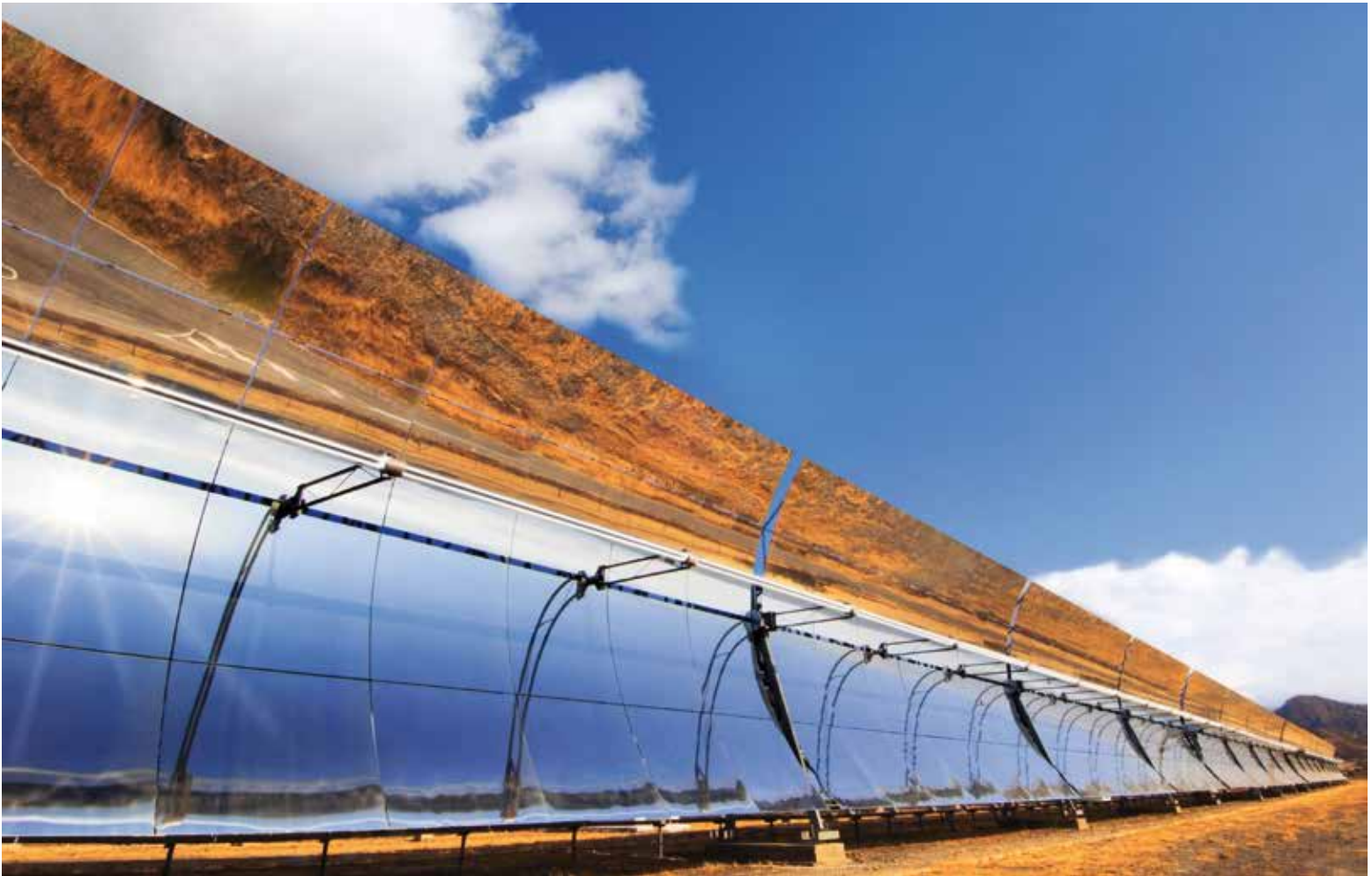
Bild 8 Parabolrinnenkollektor auf der Plataforma Solar de Almería [22], (© DLR)
