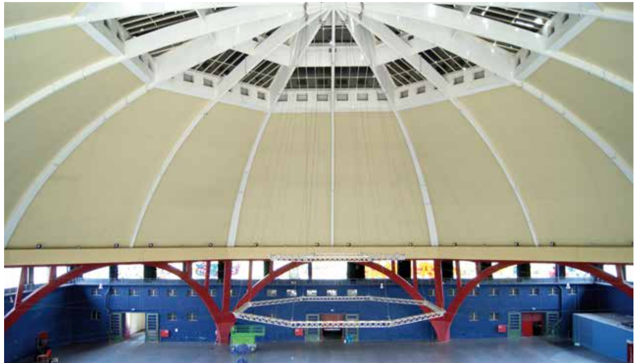
Blick in die Nordhalle (Foto: Jürgen Stritzke)
