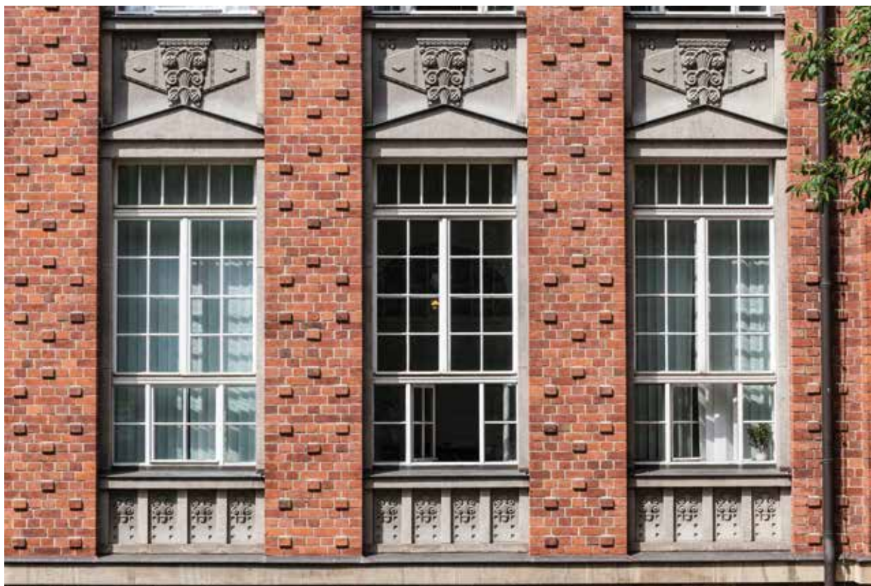
Beyer-Bau Detailansicht Südseite
