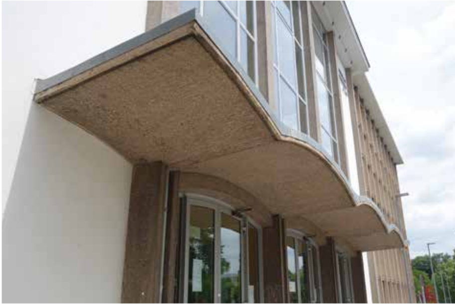
Vordach Andreas-Schubert-Bau, TU Dresden (Foto: Thomas Bösche)
