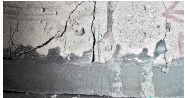
Bild 11 Rissentwicklung in einer Reparatur- bzw. Verstärkungsschicht aus hochduktilen Betonen auf einem gerissenen Stahlbetonuntergrund (Fotos: Iurie Curosu)
