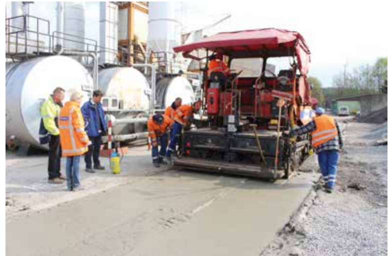
Bild 13 Einbau des hochduktilen Betons mittels Walzenfertiger (links) bzw. Asphaltfertiger (rechts) (Fotos: Steffen Müller)
