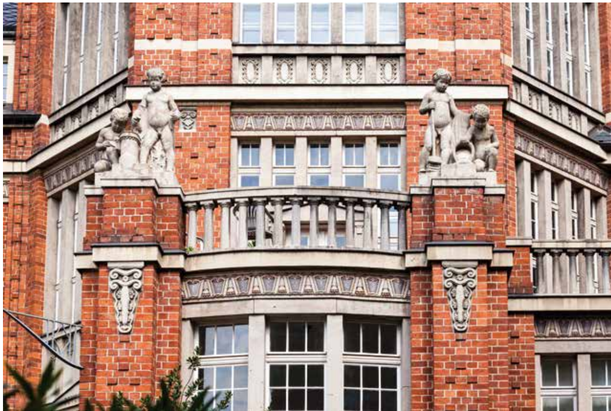
Beyer-Bau Balkon mit Zierfiguren über dem Eingang George-Bähr-Straße
