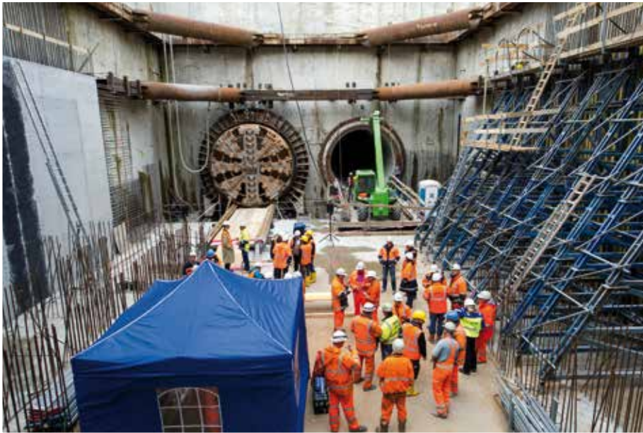
Zeremonie zur Ankunft der Tunnelbohrmaschine AMELI im finalen Zielschacht am 4. Juni 2012 (Foto: © European XFEL)
