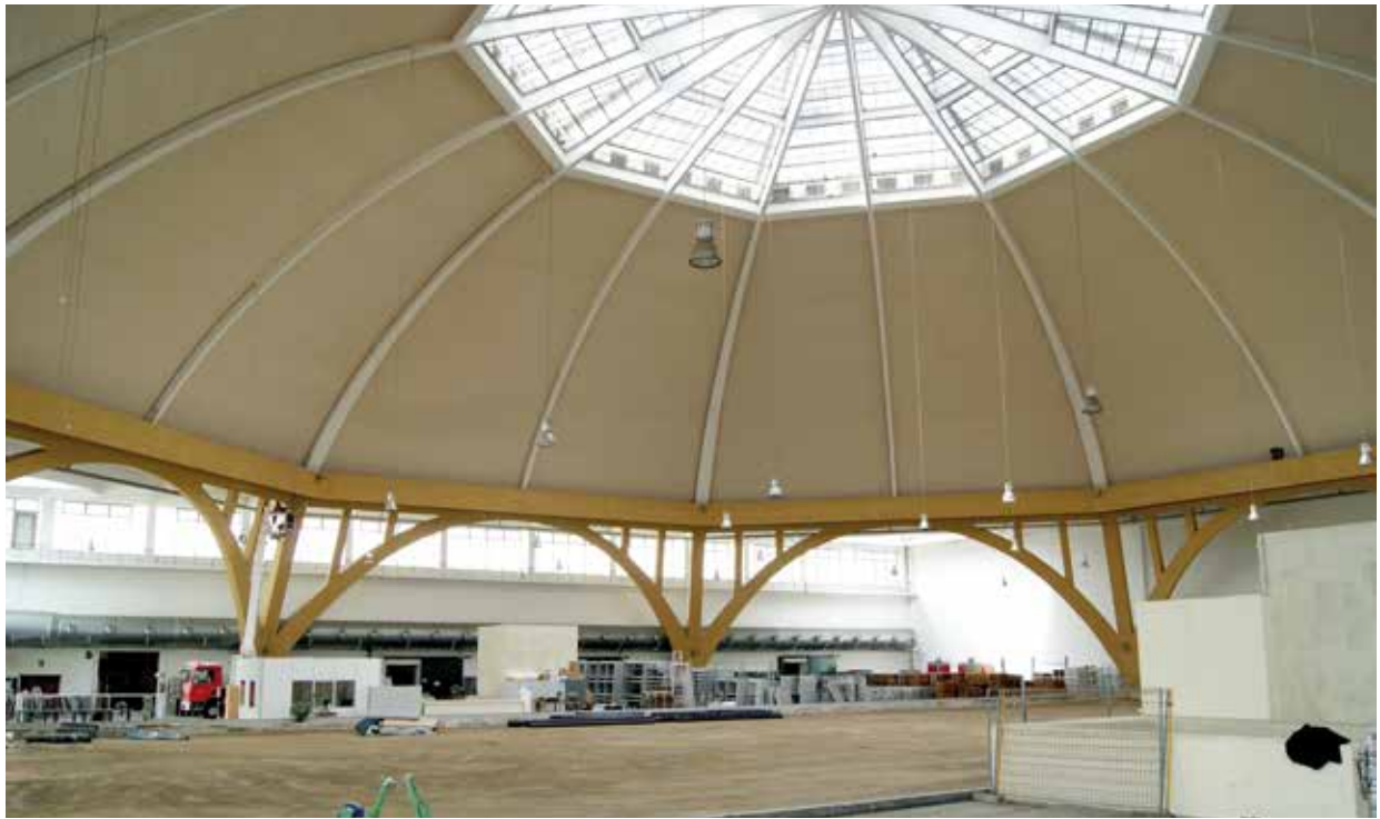
Blick in die Südhalle mit Laterne, Kuppelschale, Zugring, Tragbögen und Eckstützen (Foto: Jürgen Stritzke)
