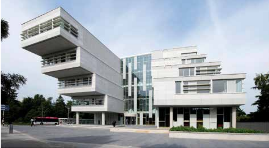
Bild 2 Anwendungsbeispiel eines filigranen Textil- betonbaus: hinterlüf- tete Fassadenplatten, Nimwegen (Foto: Ben Vulkers, LIAG Architecten)
