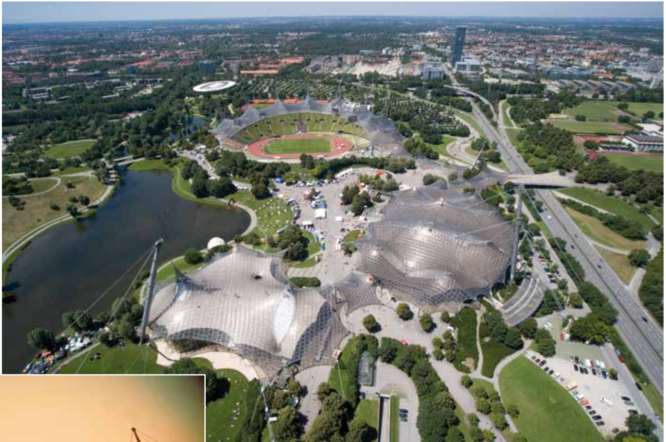
Anwendung der Prinzipien des Leichtbaus, hier beim Dach des Olympiastadions in München, 1972
