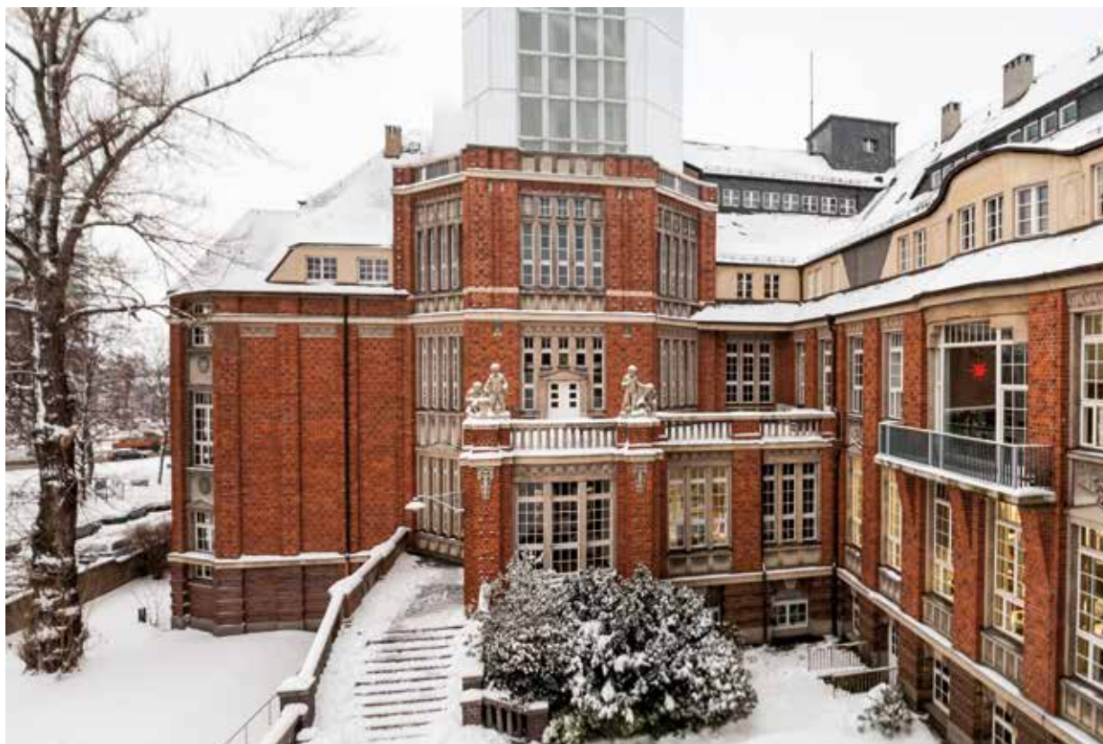
Beyer-Bau Eingangsbereich, Blick aus dem Hörsaal 98
