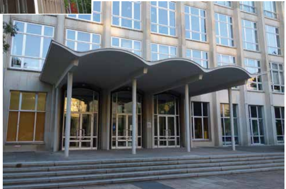
Vordach der Mensa Reichenbachstraße, Dresden (Foto: Thomas Bösche)
