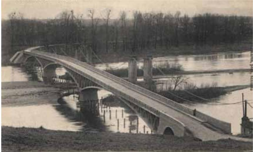
Die erste Brücke von Freyssinet mit unbewehrten Betongelenken:
