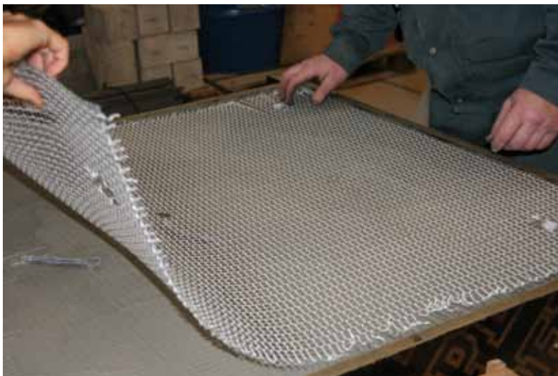
Aufbringen der Stahlgewebe- verstärkungsschicht Application of steel fabric reinforcement
