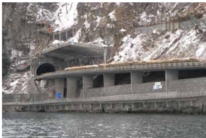
DA Sipos Steinschlagschutzgalerie
