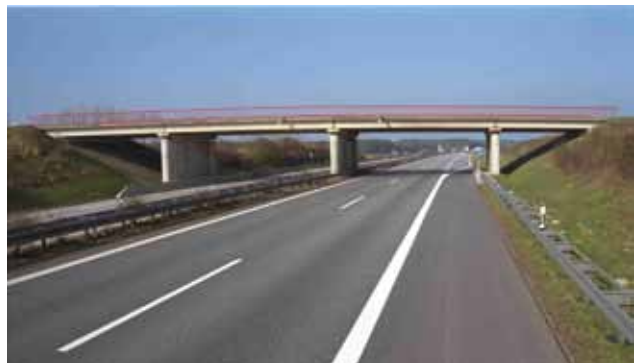
Ansicht einer Fertigteil-Typenbrücke
