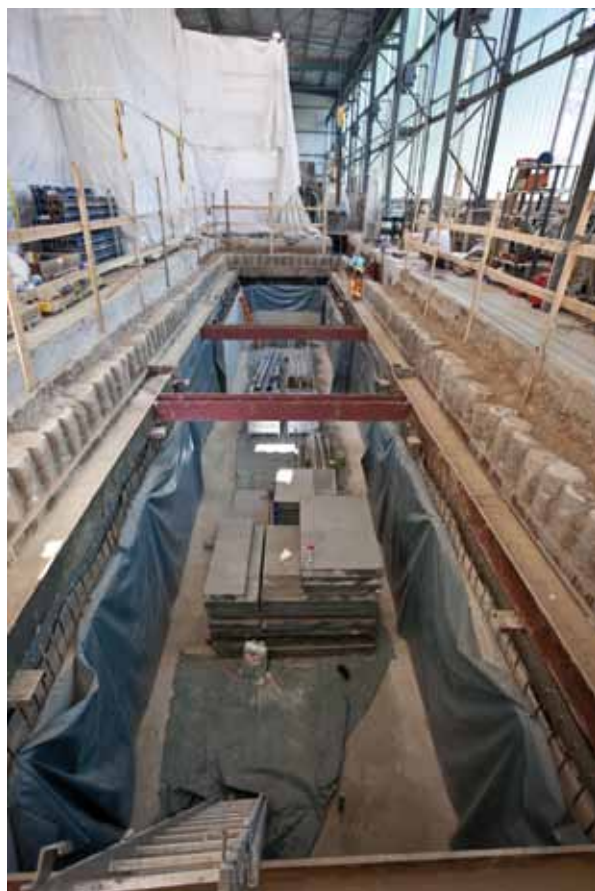
10-Meganewton-Säulenprüfmaschine : Baugrube – Aufbau – fertige Säulenprüfmaschine
