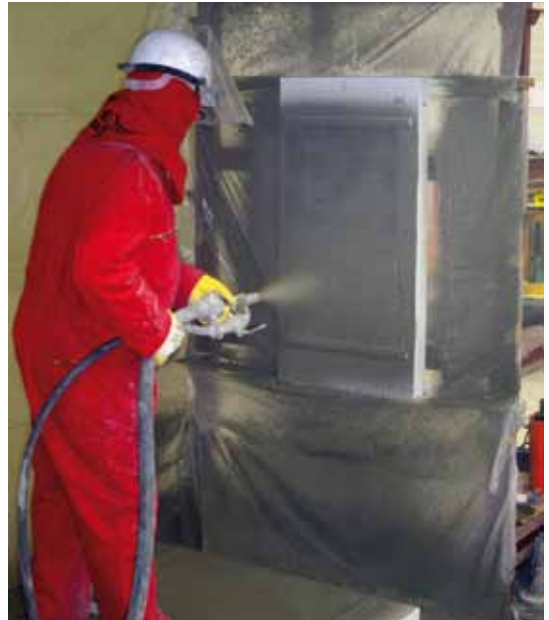
Applikation des Feinbetons mit dem Nasssprühverfahren
