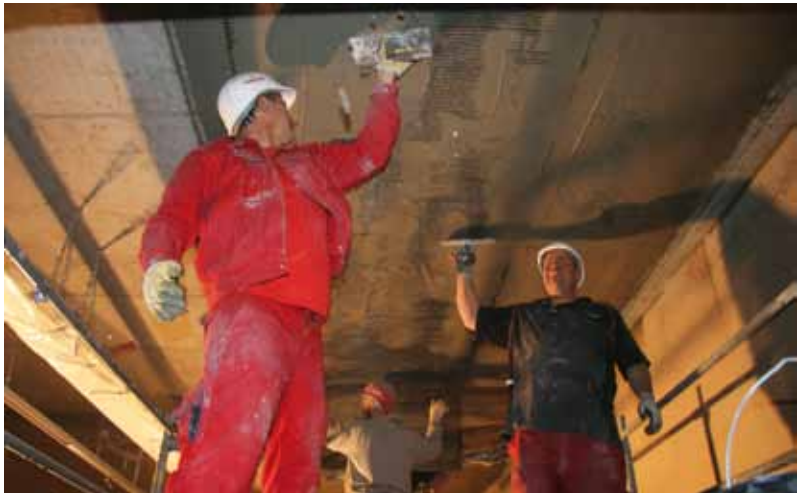
Aufbringen der Textilbetonverstärkung Application of textile reinforced concrete
