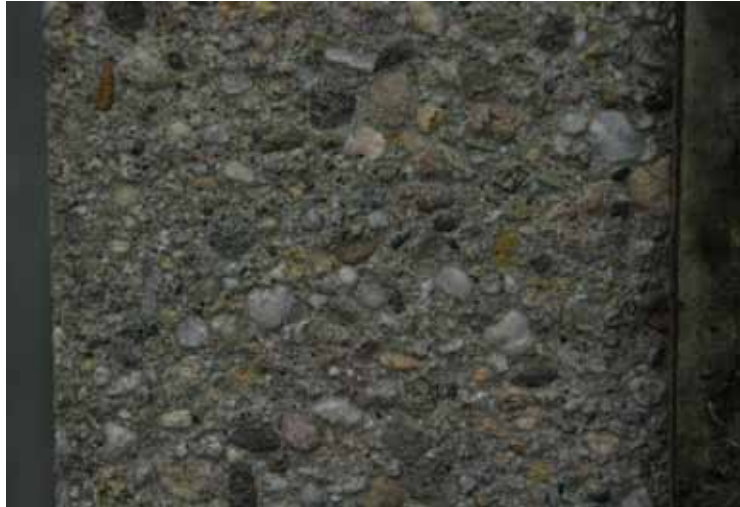
Sandgestrahlte Oberfläche Sandblasted surface
