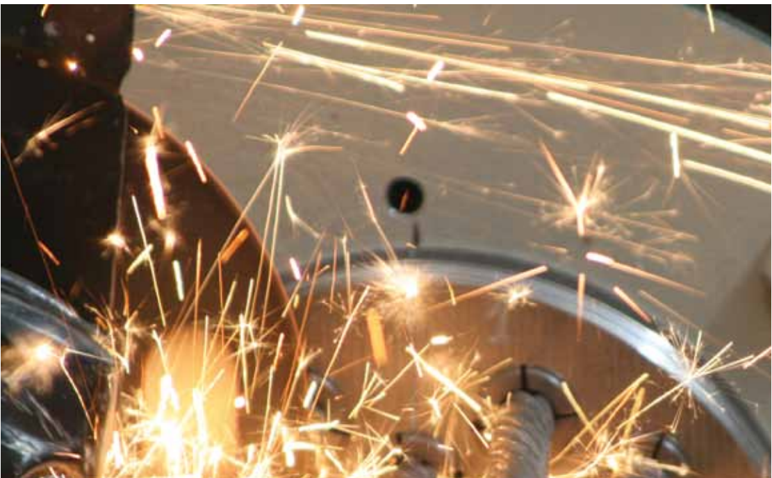
Abtrennen (abflexen) überstehender Enden bei einem Spannglied
