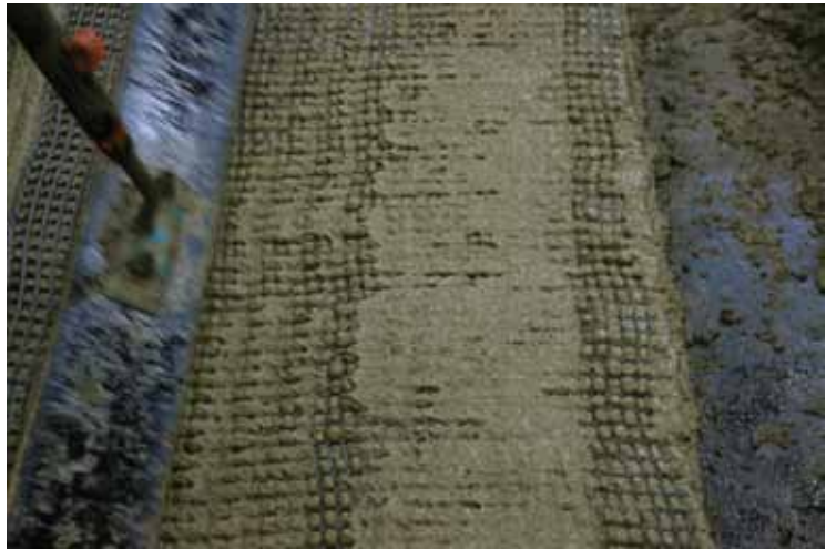
Einarbeiten der textilen Carbonbewehrung Assembling the textile Carbon reinforcement
