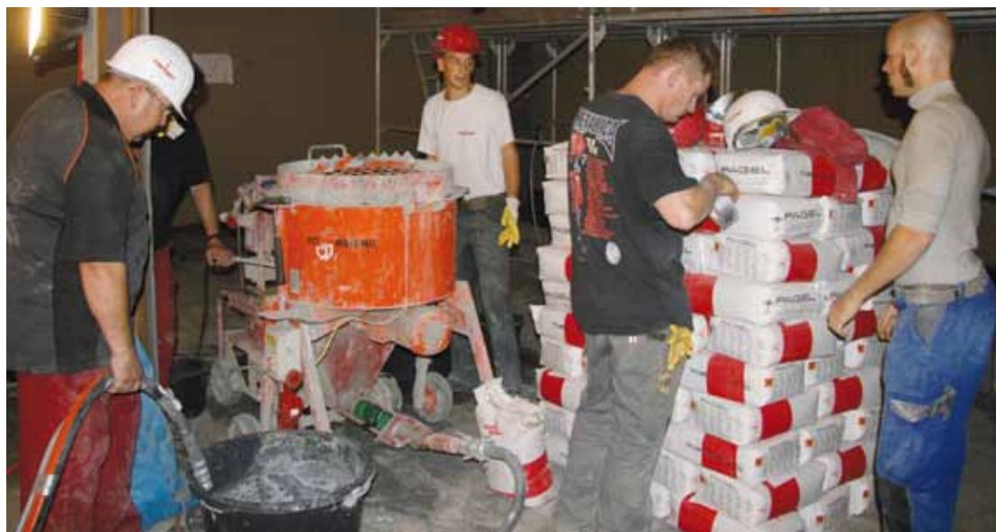
Mischplatz für den Feinbeton Mixing area for the fine grain concrete
