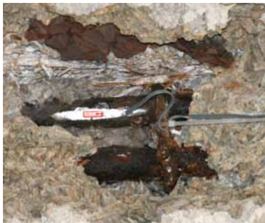
Verformungsmessung an einem Bewehrungsstahl an der Deckenunterseite
