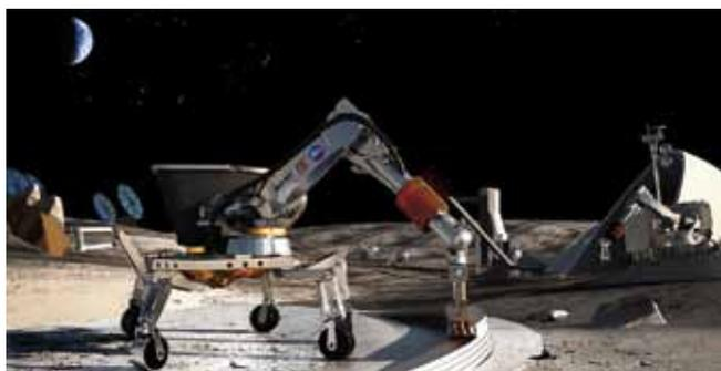
Fertigung einer permanenten lunaren Konstruktion mittels Lunar Contour Crafting
