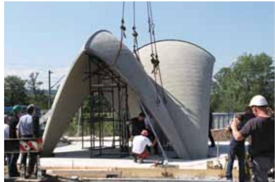
Montage eines Gebäudes aus schalenförmigen Textilbetonfertigteilen
